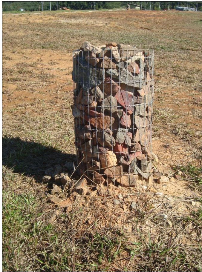
Figura 6 – Sistema de drenagem e queima dos gases. Fonte: Cirsures.
