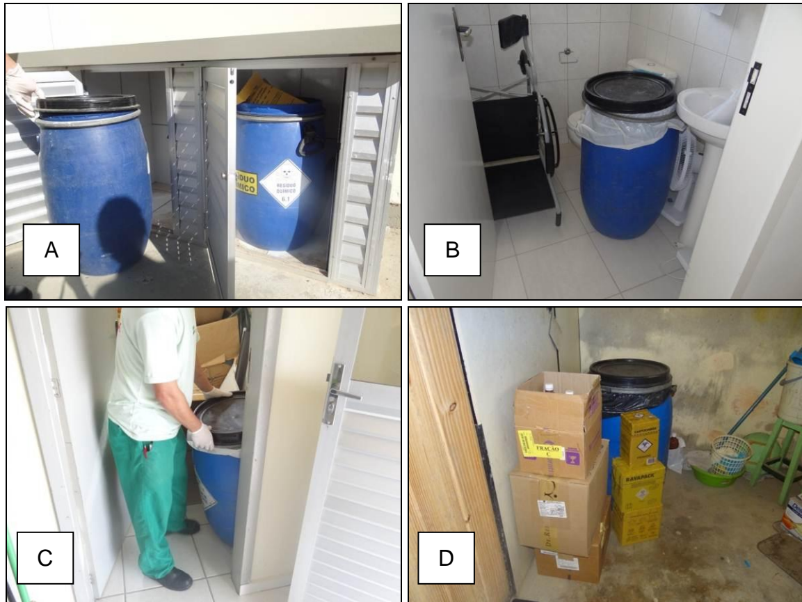
Figura 83 – A) Abrigo externo dos RSS na ESF Estação; B) Local utilizado como abrigo externo na ESF Nova Itália; C) Abrigo externo de RSS na ESF Dr. Luiz Campelli; D) Abrigo externo ESF Centro. Julho de 2012.
