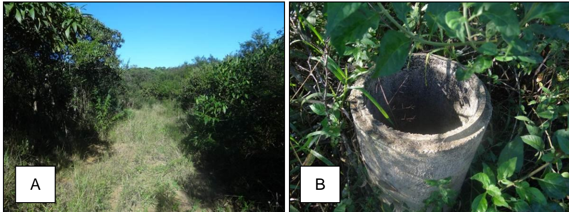
Figura 59 – A) Área recuperada do antigo lixão de Orleans; B) Dreno para captação e queima de gases. Julho de 2012.
