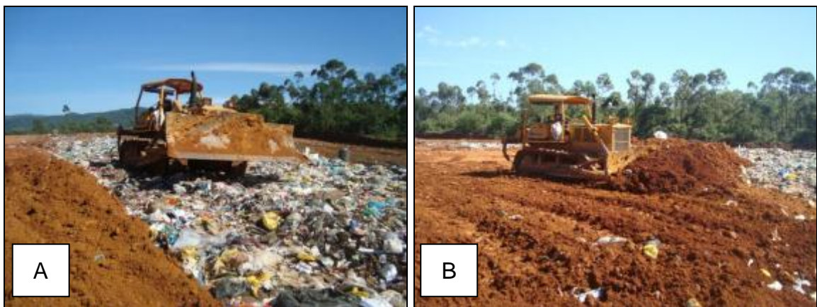
Figura 5 – A) Compactação da massa de lixo; B) Cobertura do lixo com argila. Fonte: Cirsures, 2011.
