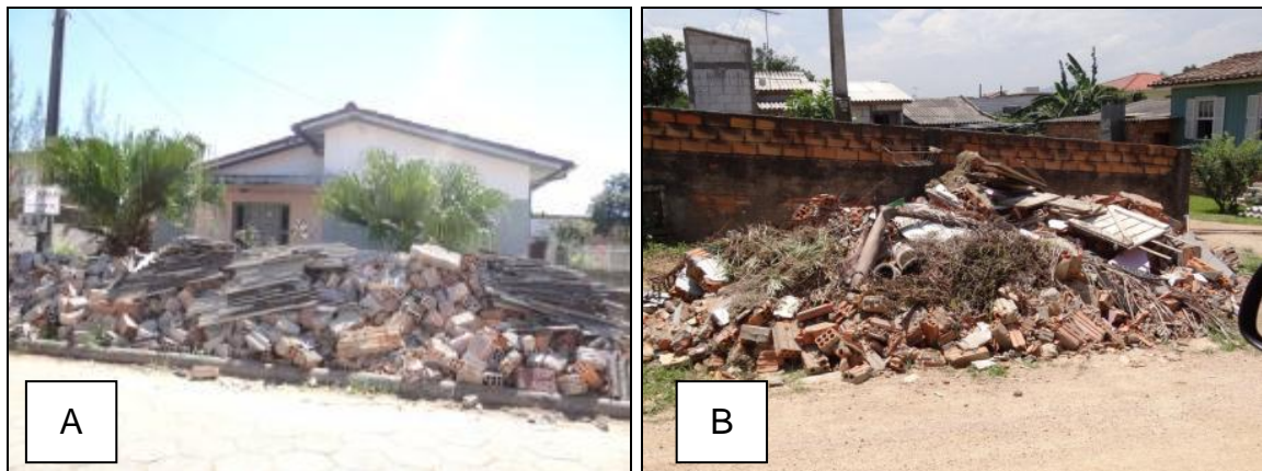
Figura 44 – A) RCD dispostos na calçada de uma residência na Rua Valmor Napolini, Bairro Napolini; B) Disposição irregular de RCD na Rua Sérgio Búrigo, Distrito Estação Cocal. Janeiro de 2012.
