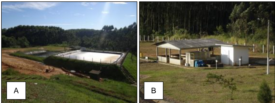
Figura 7 – A) Lagoas anaeróbicas; B) ETE, tratamento físico-químico. Fonte: Cirsures, 2011.
