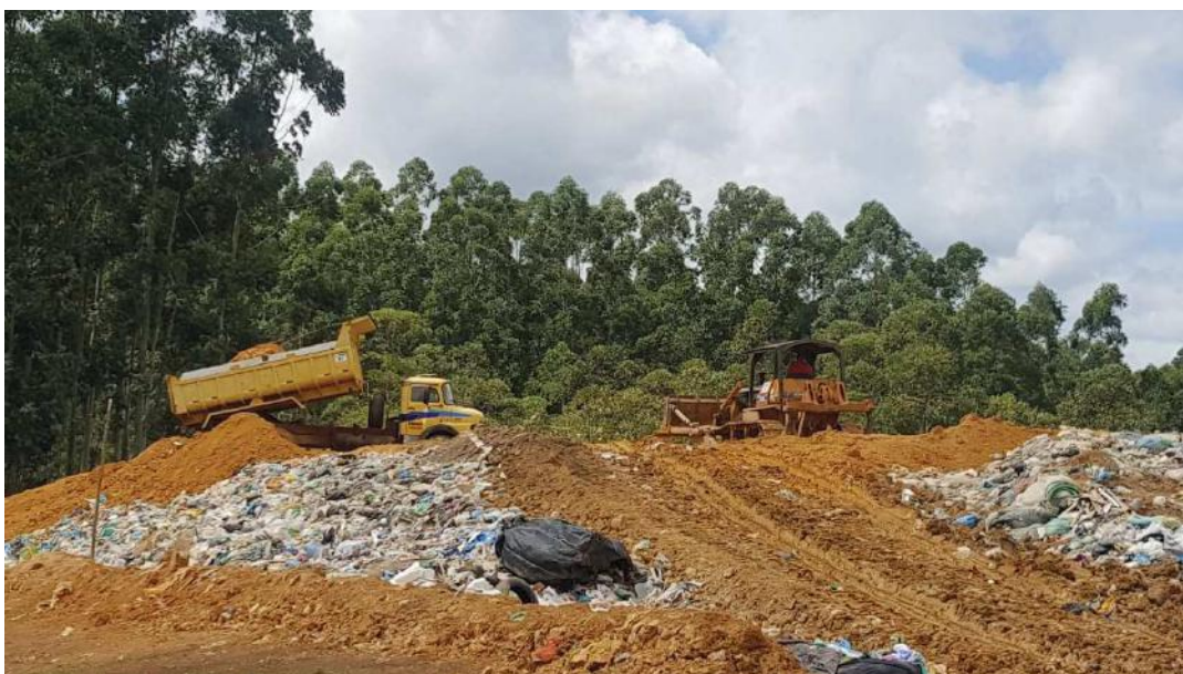
Figura 4: Operação do aterro frente de serviço, fevereiro de 2018.
