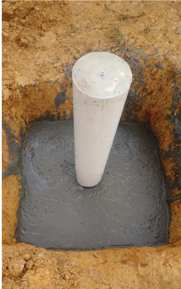
Figura 2: Concretagem final dos marcos nas covas previamente escavadas.
