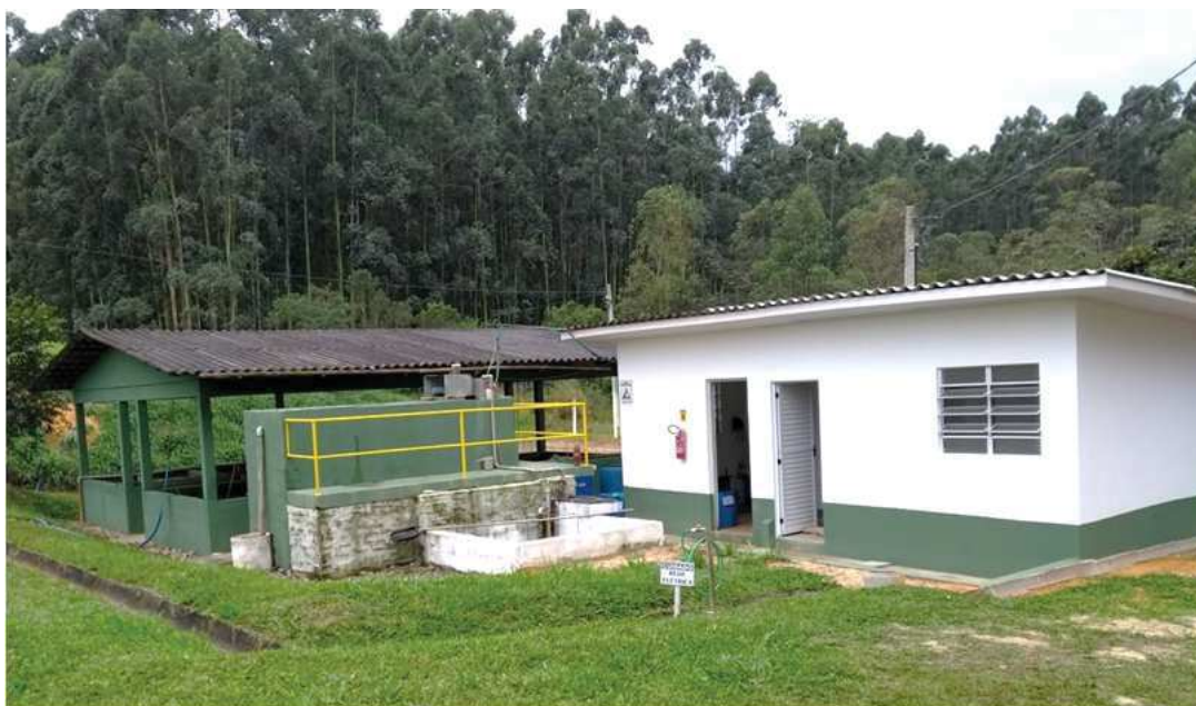
Figura 12: Tratamento Físico-Químico, destaque para ampliação da casa de química, abril de 2018.
