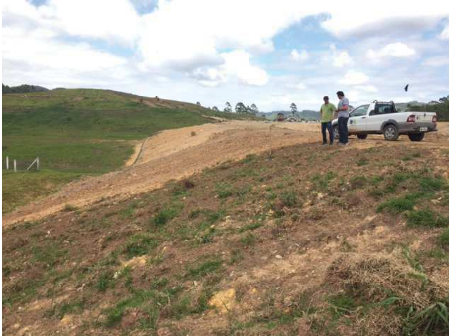
Figura 5: Detalhe da porção sul do talude do novo módulo de resíduos onde se observa a drenagem de pé de talude e o desenvolvimento da cobertura vegetal.
