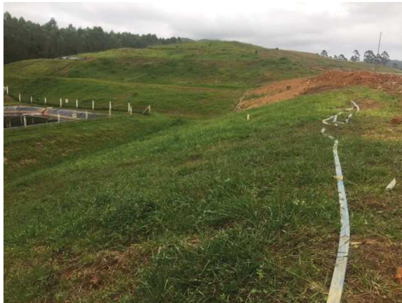
Figura 5: Detalhe da porção sul do talude onde se observa o desenvolvimento bastante expressivo da cobertura vegetal.
