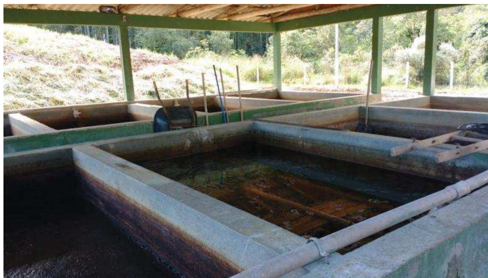
Figura 45: Leito de secagem de lodo, maio de 2017.
