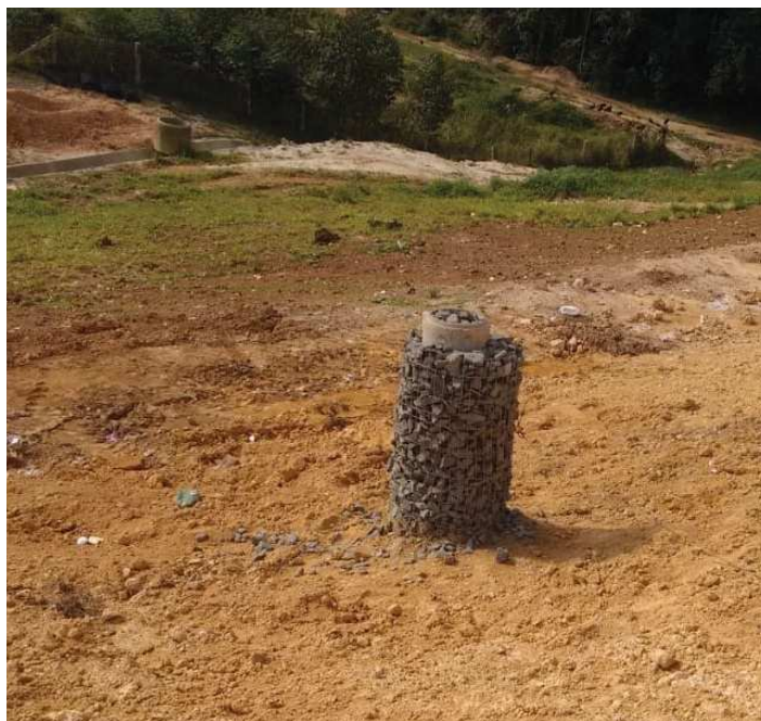
Figura 6: Queimador de gás do aterro sanitário, abril de 2018.
