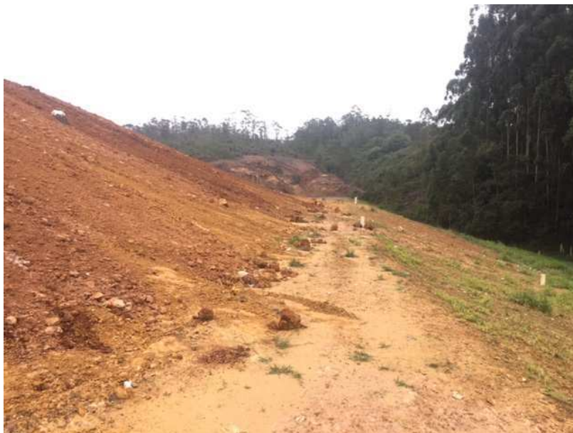
Figura 8: Detalhe da berma entre os taludes da primeira e segunda bancada.
