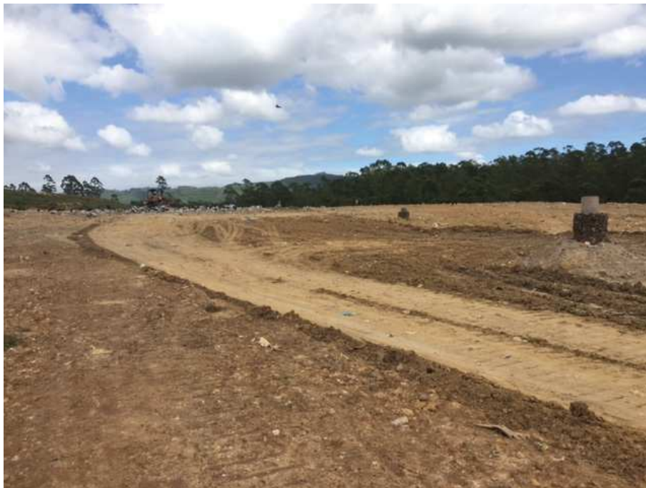
Figura 4: Detalhe da superfície do novo módulo onde será iniciada a deposição referente ao segundo patamar.
