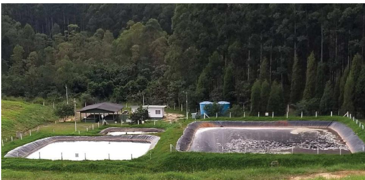
Figura 8: Lagoas anaeróbias 1 e 2 - Sistema de tratamento de chorume. Ao fundo sistema de tratamento físico-químico, abril de 2018.
