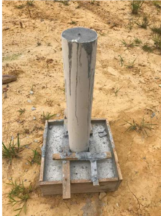
Figura 1: Blocos de concreto utilizadas para fixação e nivelamento dos marcos.
