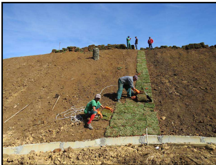
Figura 04: Aplicação de solo fértil e plantio de gramíneas nos taludes finalizados, junho de 2013.
