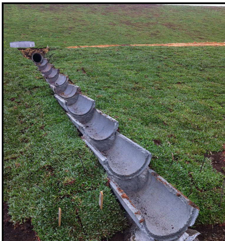
Figura 05: Instalação dos dissipadores de energia, julho de 2013.
