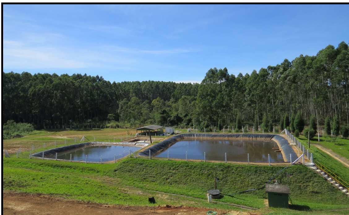
Figura 07: Vista geral do tratamento de efluentes, julho de 2013.
