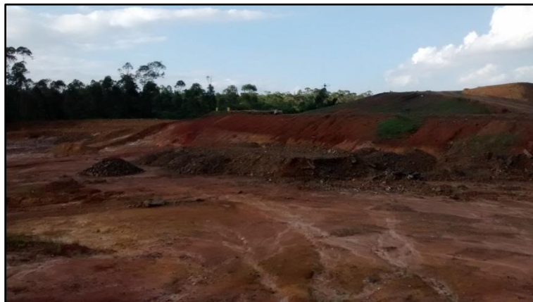
Figura 41: Jazida de material para recobrimento, abril de 2015.
