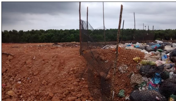
Figura 40: Cercamento provisório da frente de serviço, abril de 2014.
