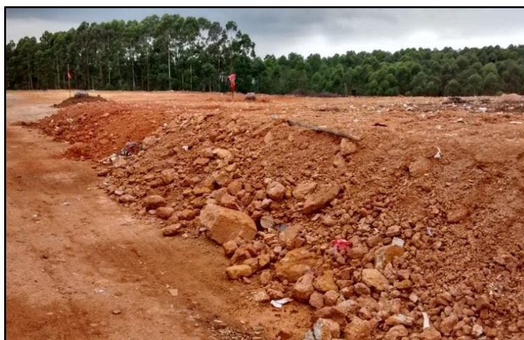
Figura 43: Nivelamento do talude do aterro sanitário, abril de 2015.
