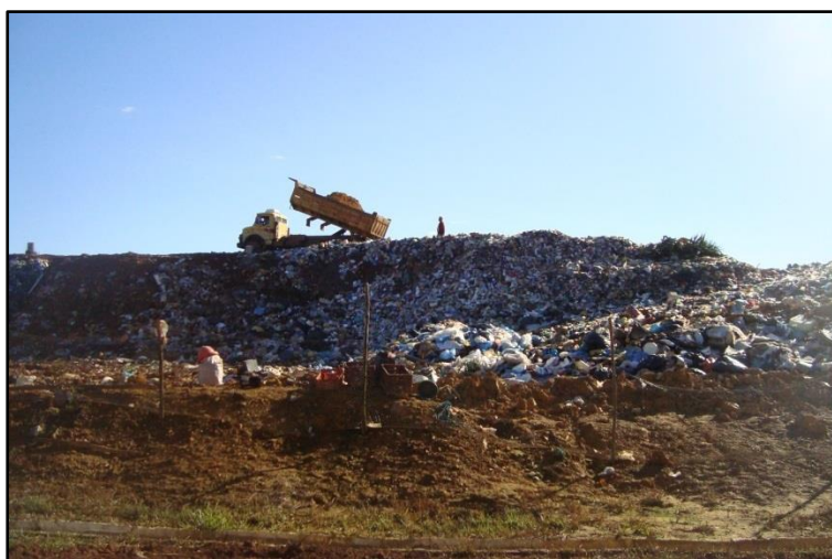
Figura 2: Frente de serviço, janeiro de 2015.
