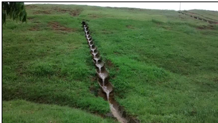
Figura 45: Manutenção do sistema de drenagem pluvial, abril de 2015.
