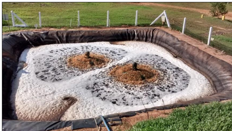
Figura 7: Lagoa aerada - Sistema de tratamento de chorume, abril de 2015.
