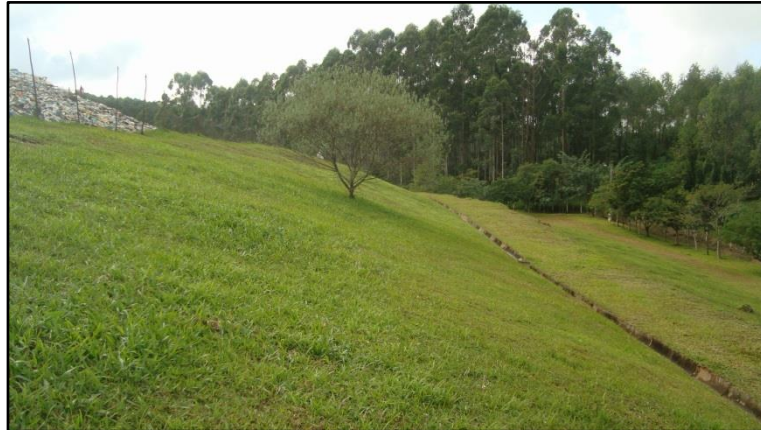
Figura 44: Grama plantada nas faces dos taludes, abril de 2014.
