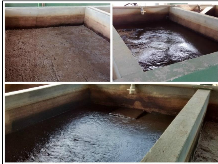
Figura 47: Leito de secagem de lodo, março de 2015.
