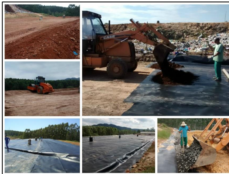
Figura 64: Conclusão da obra de impermeabilização.
