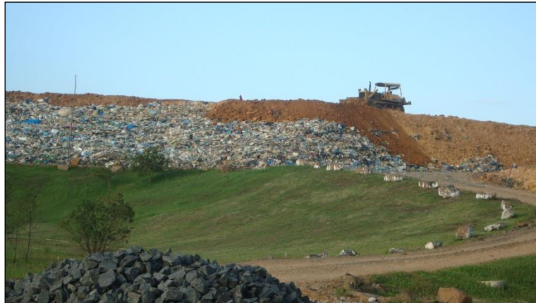
Figura 39: Recobrimento dos RSU, abril de 2014.
