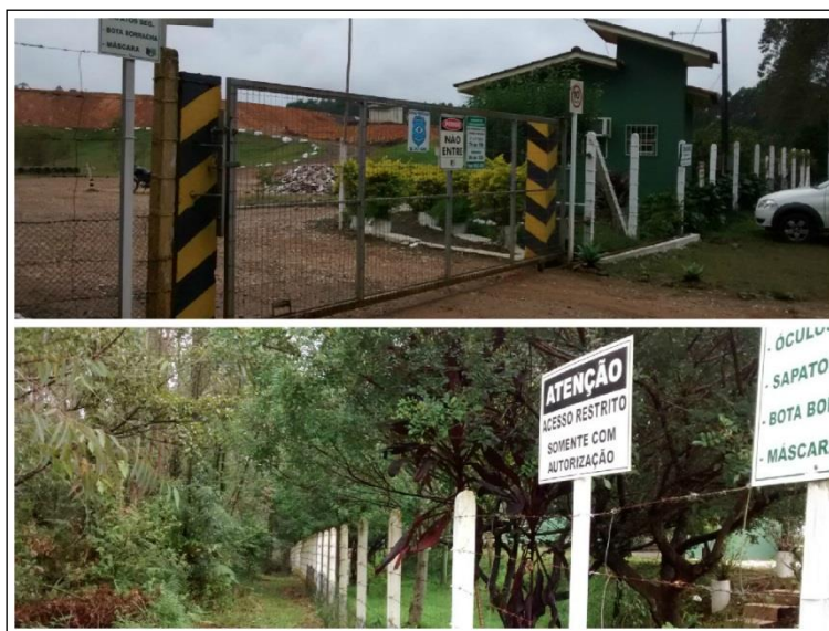
Figura 11: Cerca perimetral e portão de acesso, abril de 2014.
