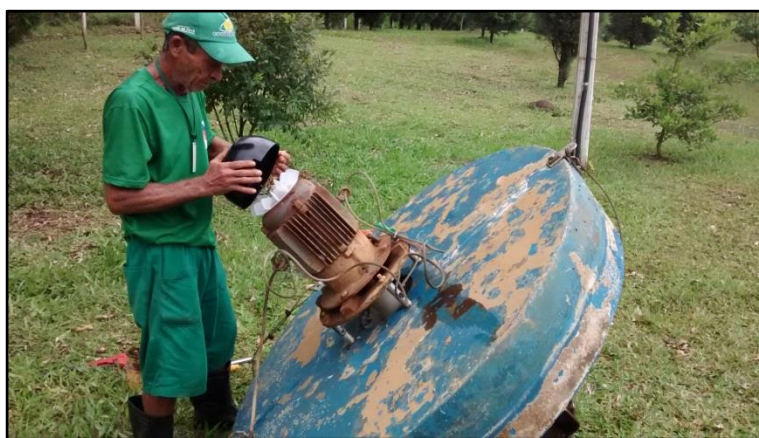
Figura 46: Troca da hélice, ventoinha e chapéu do motor do aerador flutuante, março de 2015.
