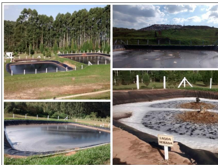
Figura 6: Lagoas anaeróbias - Sistema de tratamento de lixiviado, abril de 2015.
