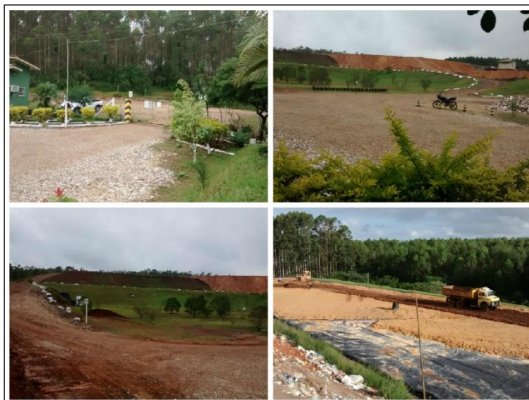
Figura 12: Acessos internos, abril de 2014.
