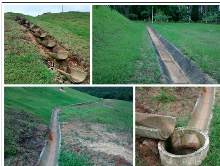
Figura 4: Sistema de drenagem pluvial, dezembro de 2014.
