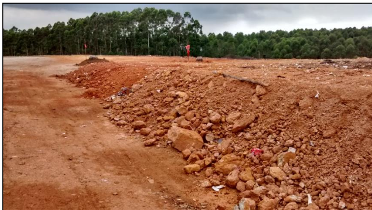
Figura 31: Nivelamento do talude do aterro sanitário, dezembro de 2014.
