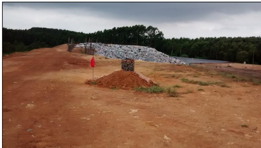
Figura 3: Queimador de gás do aterro sanitário, dezembro de 2014.
