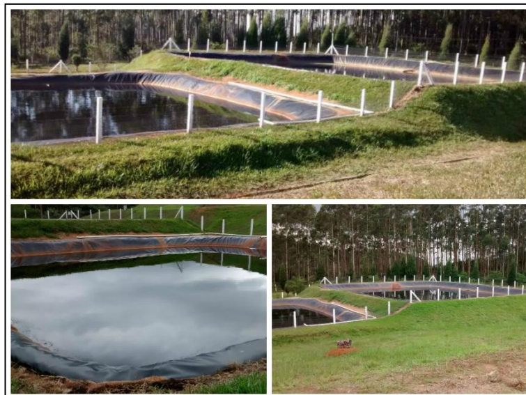
Figura 5: Lagoas anaeróbias - Sistema de tratamento de lixiviado, dezembro de 2014.
