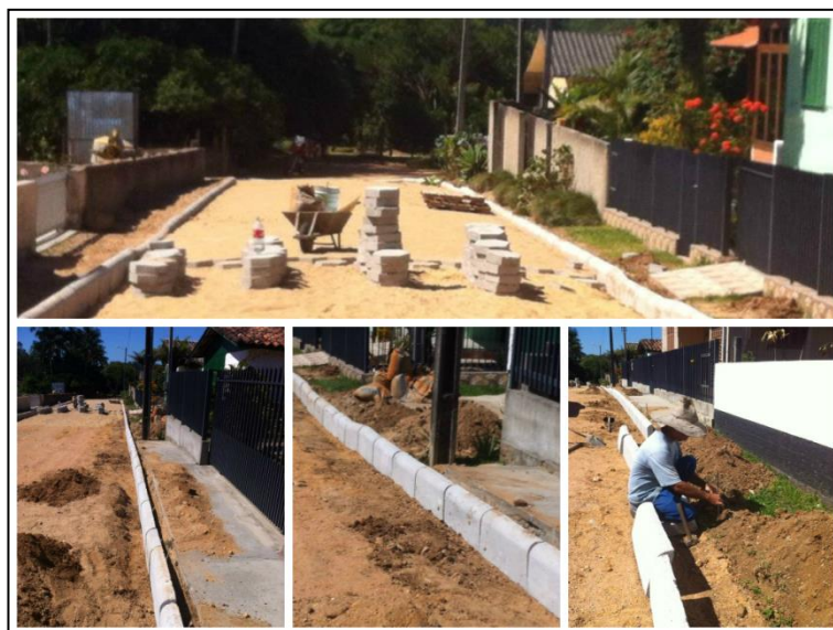
Figura 39: Pavimentação de rua no Bairro Rio América, dezembro de 2014.
