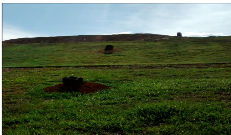
Figura 32: Grama plantada nas faces dos taludes, Dezembro de 2014.
