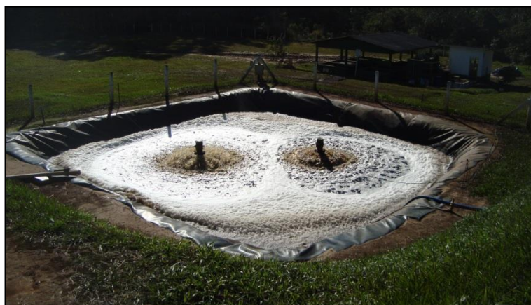
Figura 6: Lagoa aerada - Sistema de tratamento de chorume, dezembro de 2014
