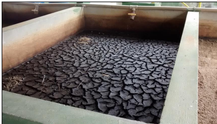
Figura 35: Leito de secagem de lodo, Dezembro de 2014.
