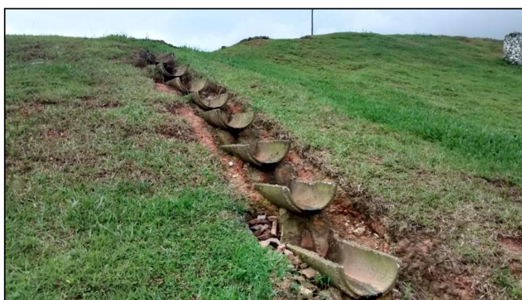
Figura 34: Manutenção do sistema de drenagem pluvial, Dezembro de 2014
