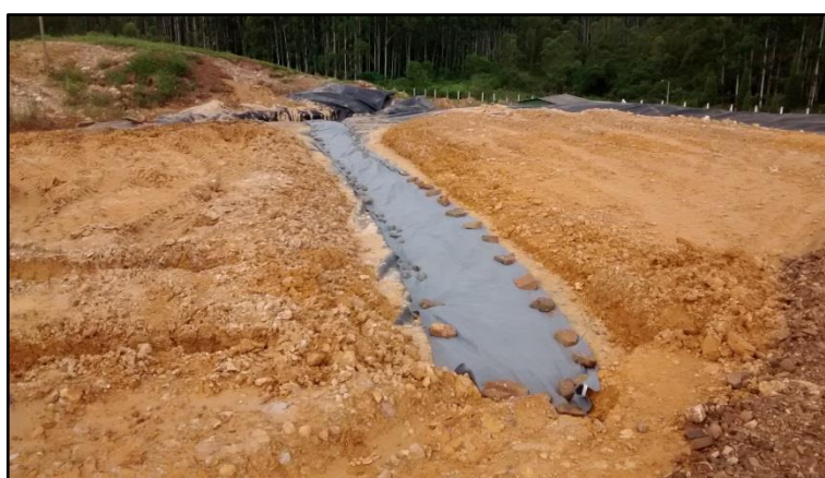
Figura 19: Colocação de geotêxtil sobre dreno secundário de drenagem de chorume.
