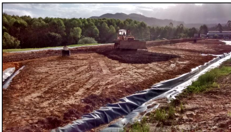
Figura 25: Construção dos acessos temporários à A1.
