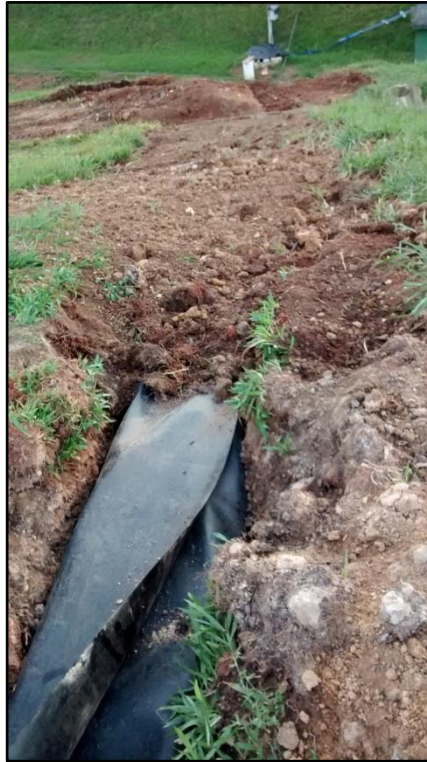
Figura 22: Impermeabilização com geomembrana e fechamento.
