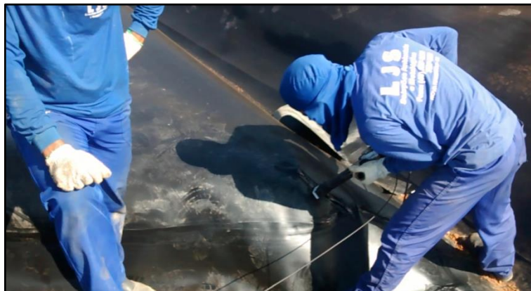
Figura 9: Solda por extrusão.
