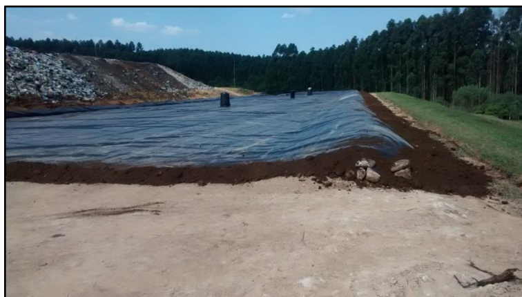
Figura 10: Ancoragem permanente da geomembrana.
