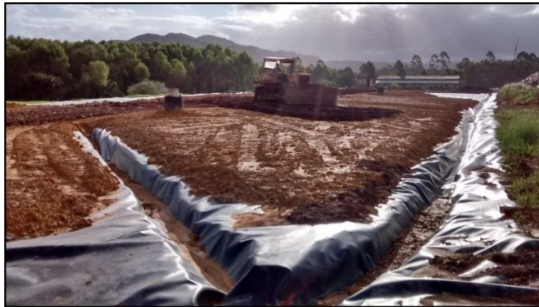
Figura 15: Visão do dreno primário e drenos secundários.
