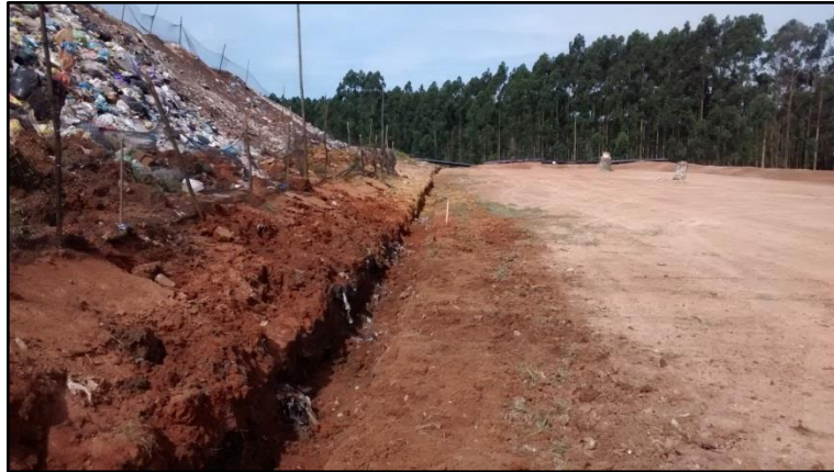
Figura 14: Drenagem principal aberta.
