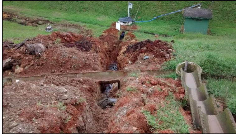
Figura 20: Abertura da vala de ligação A1 - poço de chegada.
