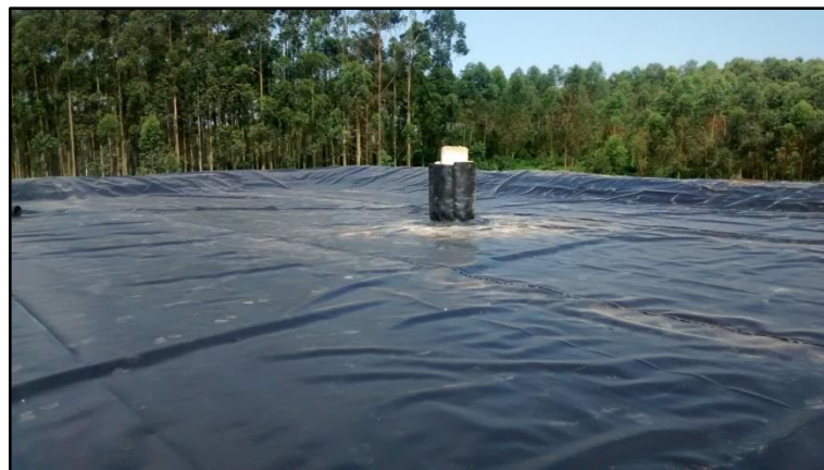
Figura 23: Envelopamento dos drenos de gases existentes.
