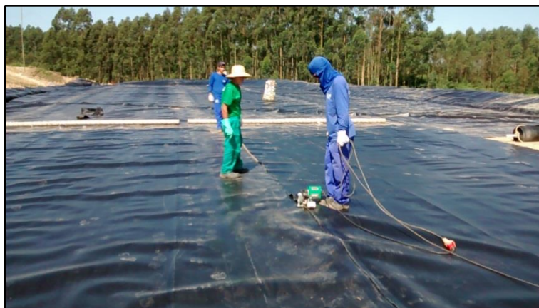
Figura 8: Emenda por termo-fusão.
