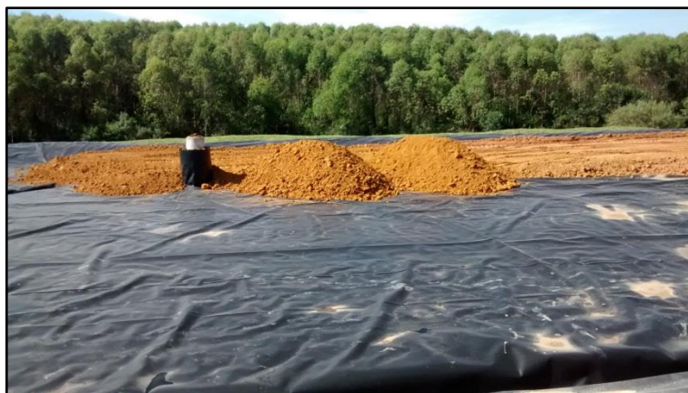
Figura 11: Colocação de argila para proteção da geomembrana.
