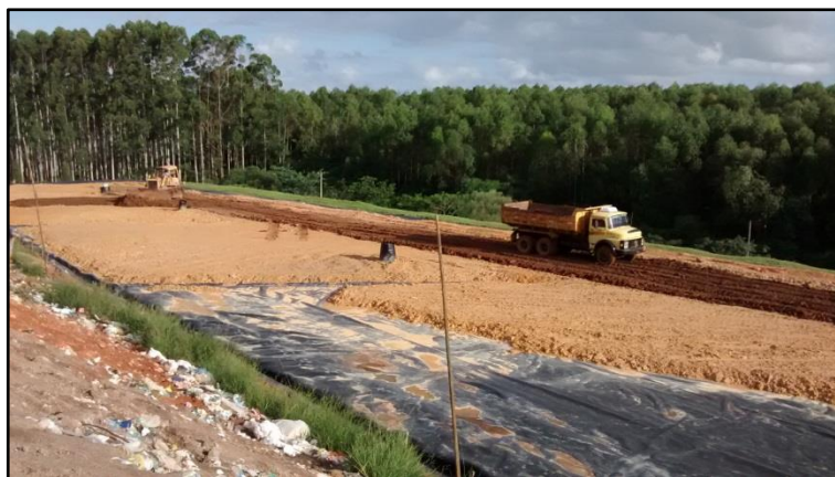
Figura 26: Construção da frente de serviço.
