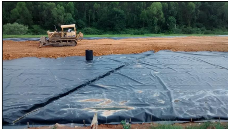
Figura 12: Compactação da camada de argila de proteção da geomembrana.
