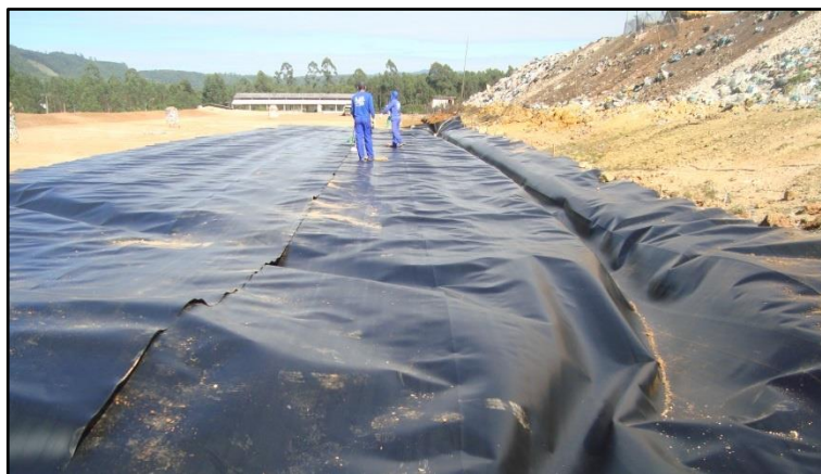
Figura 6: Instalação da geomembrana na área A1.
