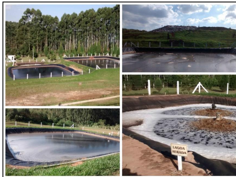
Figura 27: Lagoas de tratamento de lixiviado, abril de 2015.
