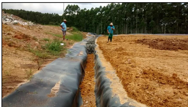
Figura 17: Colocação de brita 4 no dreno mestre.
