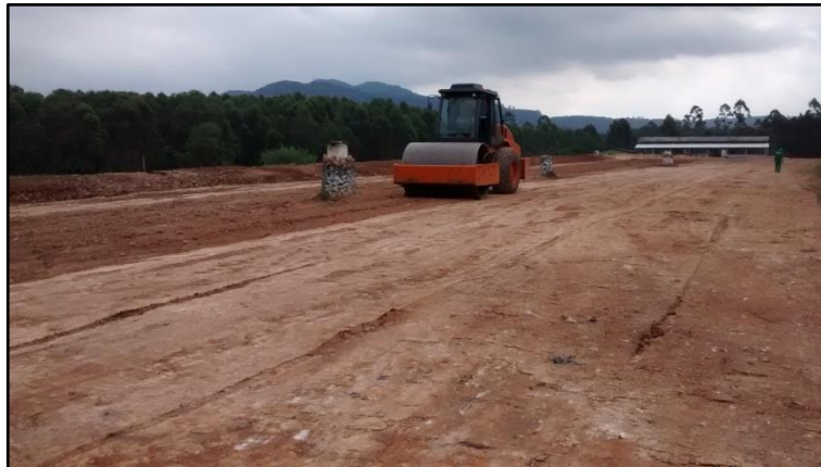
Figura 5: Compactação a superfície com rolo liso vibratório.
