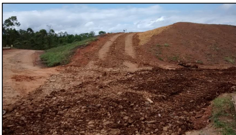
Figura 24: Cascalhamento das vias de acesso permanente.
