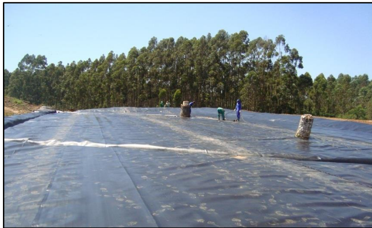
Figura 1: Área após impermeabilização.
