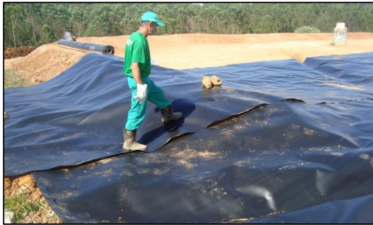
Figura 7: Modulação in loco .
