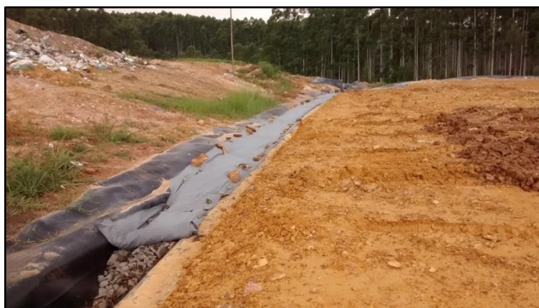
Figura 18: Colocação de geotêxtil sobre o dreno principal de chorume.
