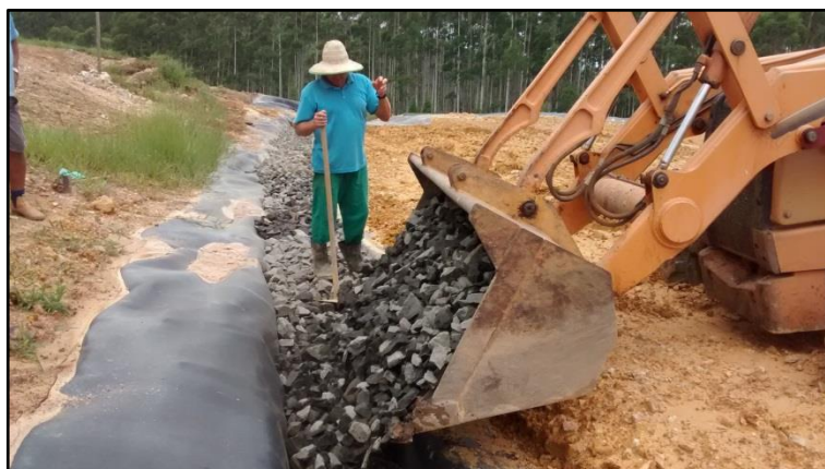
Figura 16: Colocação de brita nas valas.
