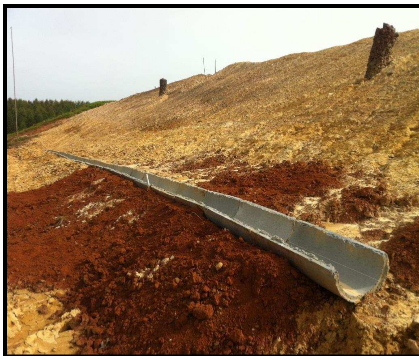
Figura 6: Instalação das novas drenagens pluviais, março de 2013.
