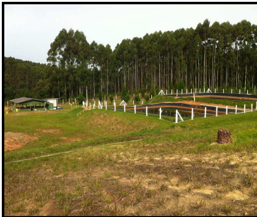
Figura 10: Vista geral do tratamento de efluentes, fevereiro de 2013.
