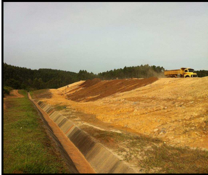
Figura 7: Aplicação de solo fértil para plantio da cobertura vegetal, março de 2013.
