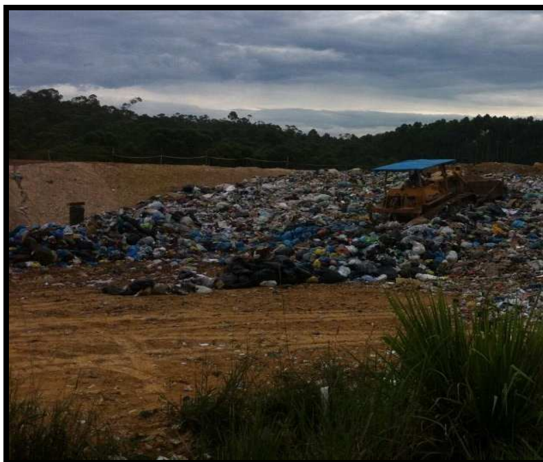
Figura 2: Compactação massa de resíduos na frente de serviço, fevereiro de 2013.
