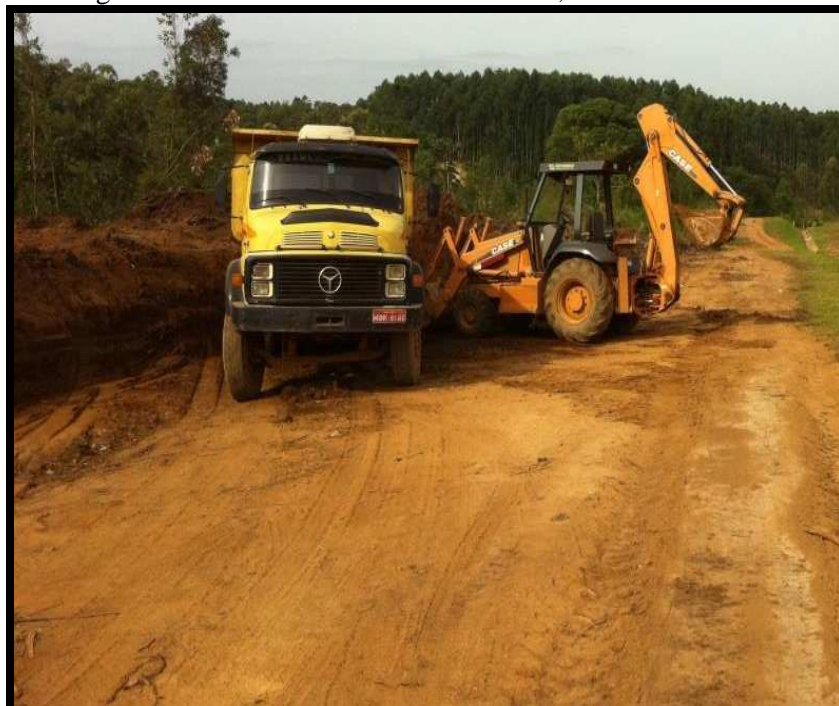
Figura 4: Material para cobertura da massa de resíduos, fevereiro de 2013.
