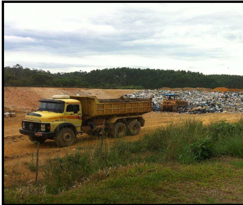
Figura 3: Cobertura da massa de resíduos, fevereiro de 2013.
