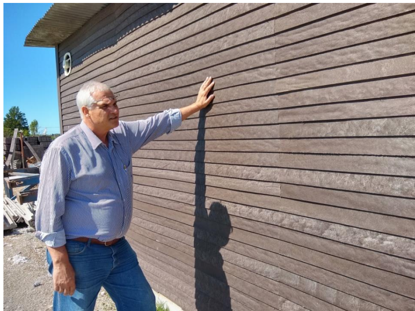
Casa de máquinas construída com madeira Biosintética.
