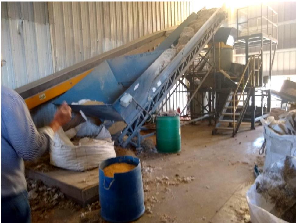
Silo de alimentação do reator de transformação, através de esteira inclinada. Ao fundo o reator que transforma os resíduos (MP) em CBSI
