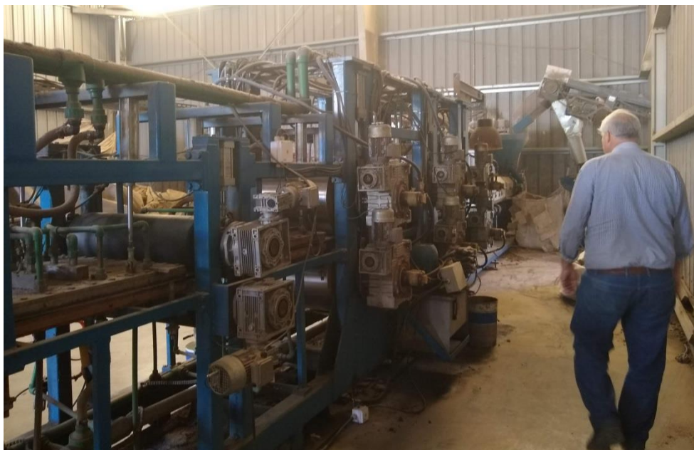
Vista lateral da extrusora/laminadora de CBSI
