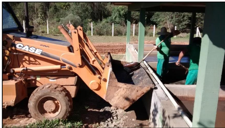
Figura 12: Limpeza dos leitos de secagem do lodo, dezembro de 2015.
