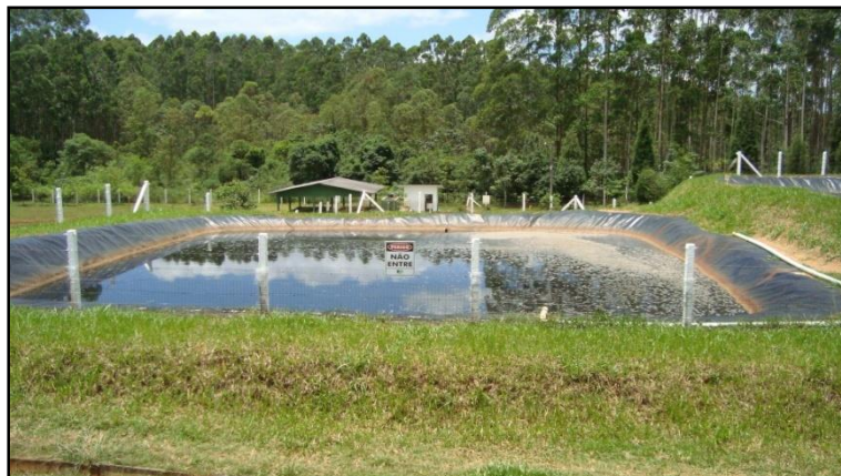
Figura 6: Lagoa anaeróbia 1 - Sistema de tratamento de lixiviado, dezembro de 2015.
