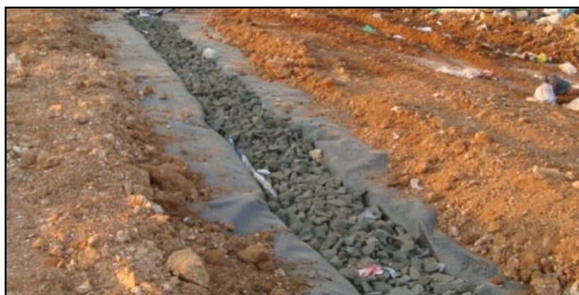
Figura 3: Sistema de drenagem de lixiviado em construção, novembro de 2015.
