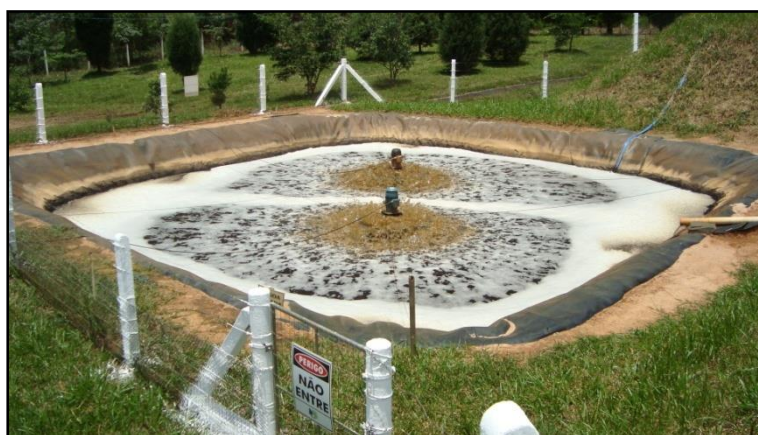
Figura 7: Lagoa aerada - Sistema de tratamento de chorume, dezembro de 2015.
