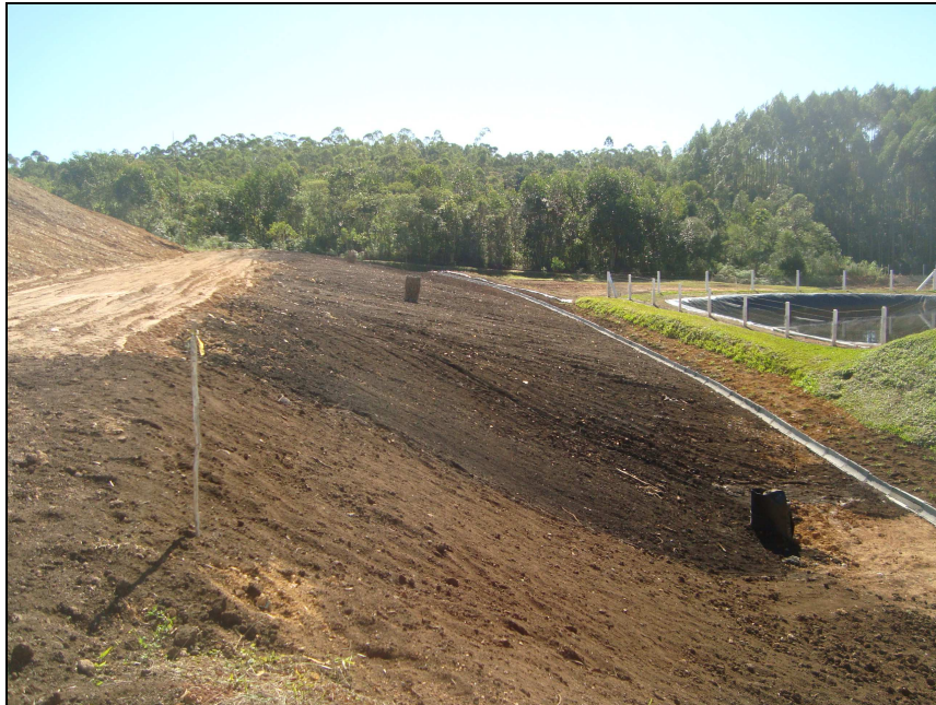
Figura 5: Vista geral dos novos taludes e drenagem pluvial, agosto de 2012.
