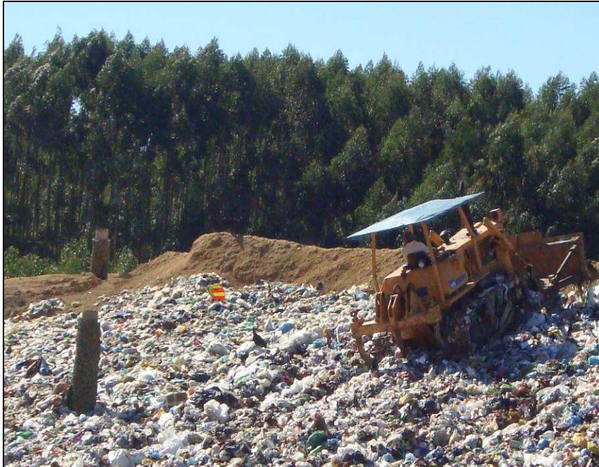
Figura 2: Compactação massa de resíduos na frente de serviço, agosto 2012.
