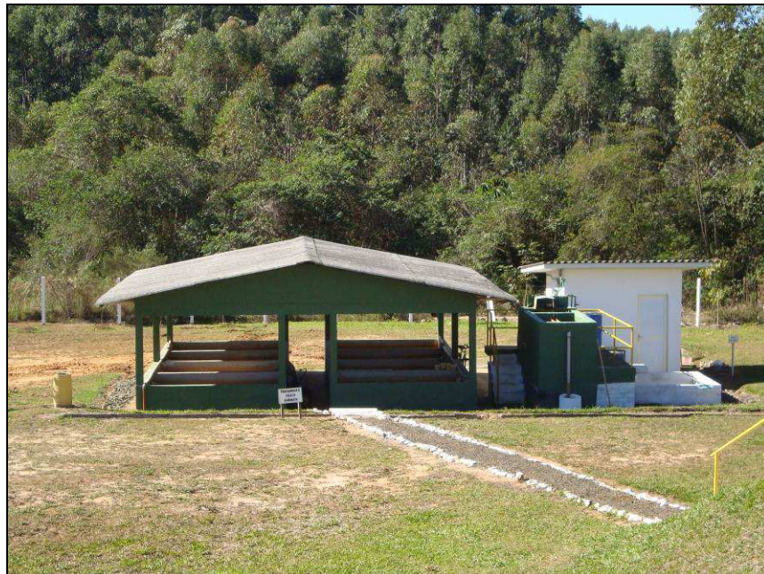
Figura 20: Vista externa do tratamento físico-químico de chorume - junho 2012.
