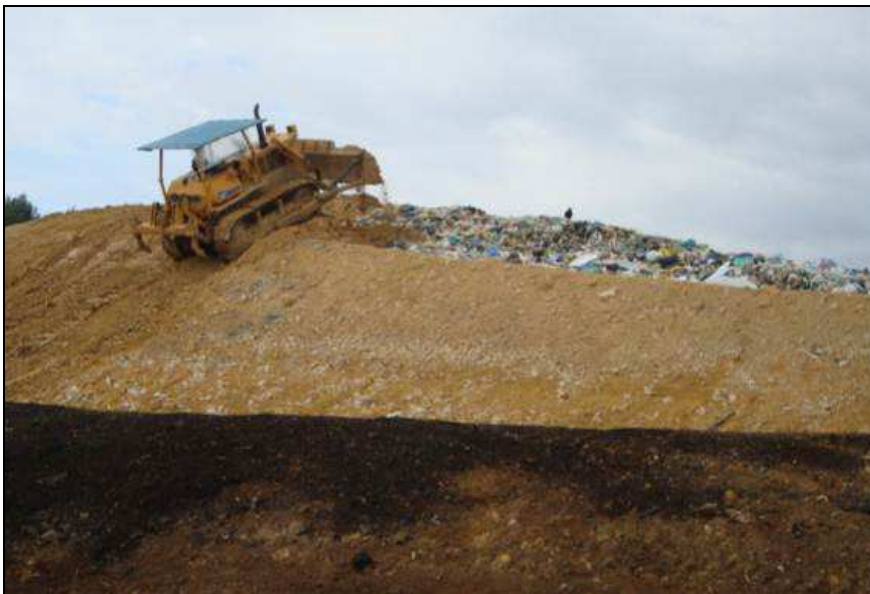
Figura 3: Quebra do talude para cobertura da massa de resíduos, agosto 2012.
