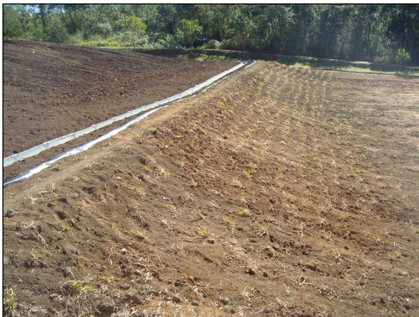
Figura 6: Plantio de gramíneas nos taludes finalizados, agosto de 2012.
