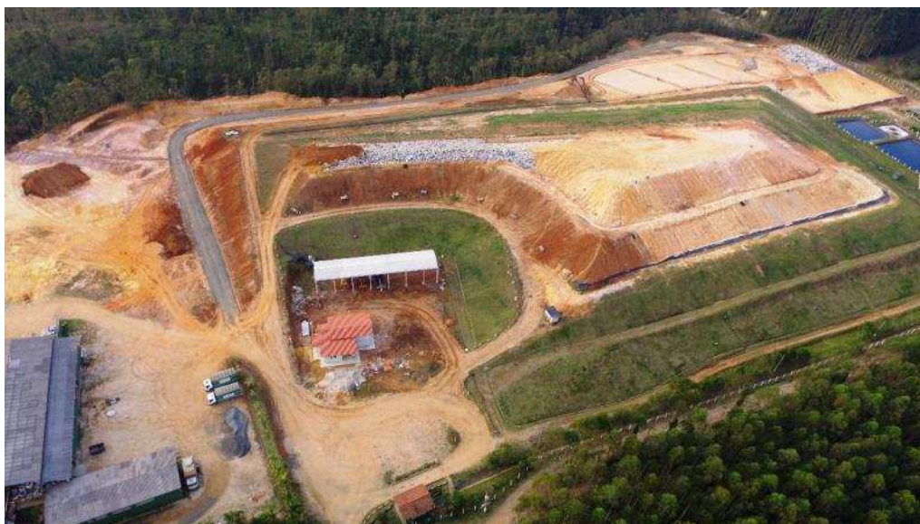
Figura 2: Vista área do aterro sanitário com 24 metros e altura, agosto 2016.
