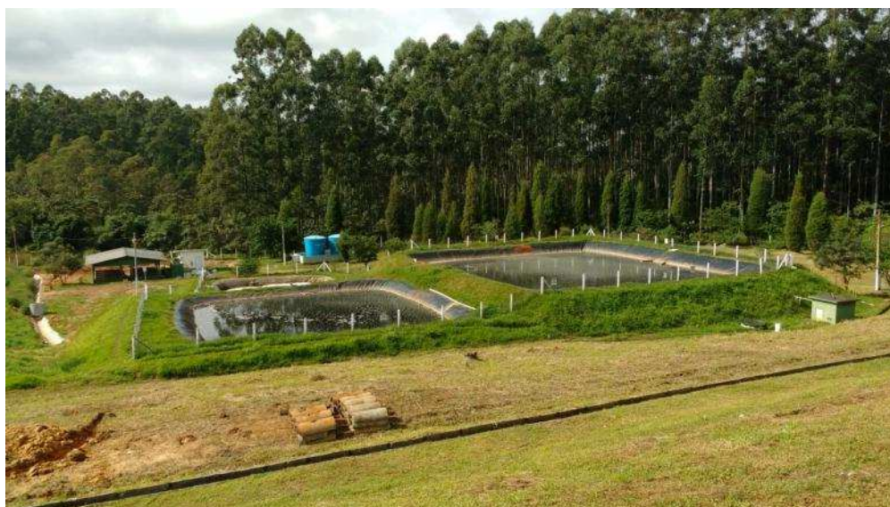
Figura 7: Lagoas anaeróbias 1 e 2 - Sistema de tratamento de lixiviado, maio de 2017.
