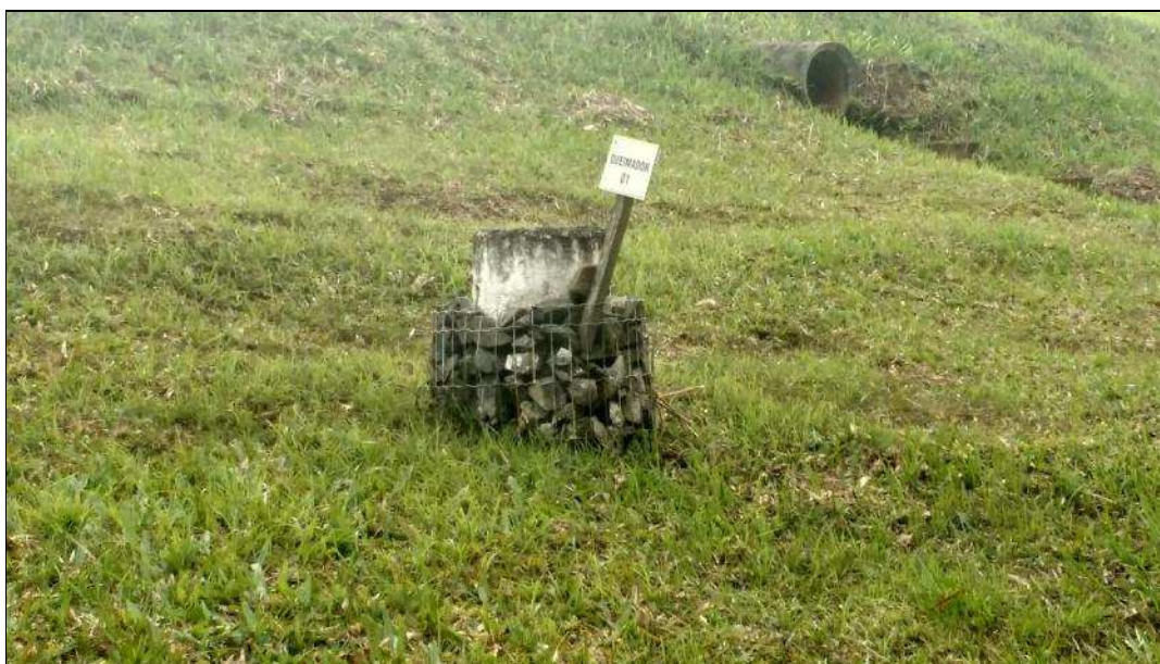
Figura 5: Queimador de gás do aterro sanitário, maio de 2017.
