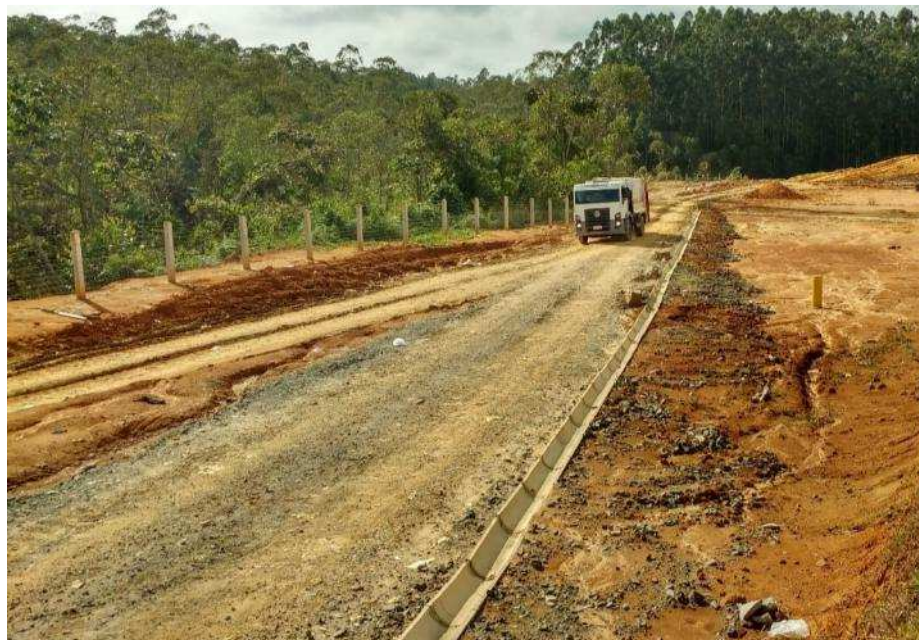
Figura 6: Sistema de drenagem pluvial e vias acesso, março de 2017.
