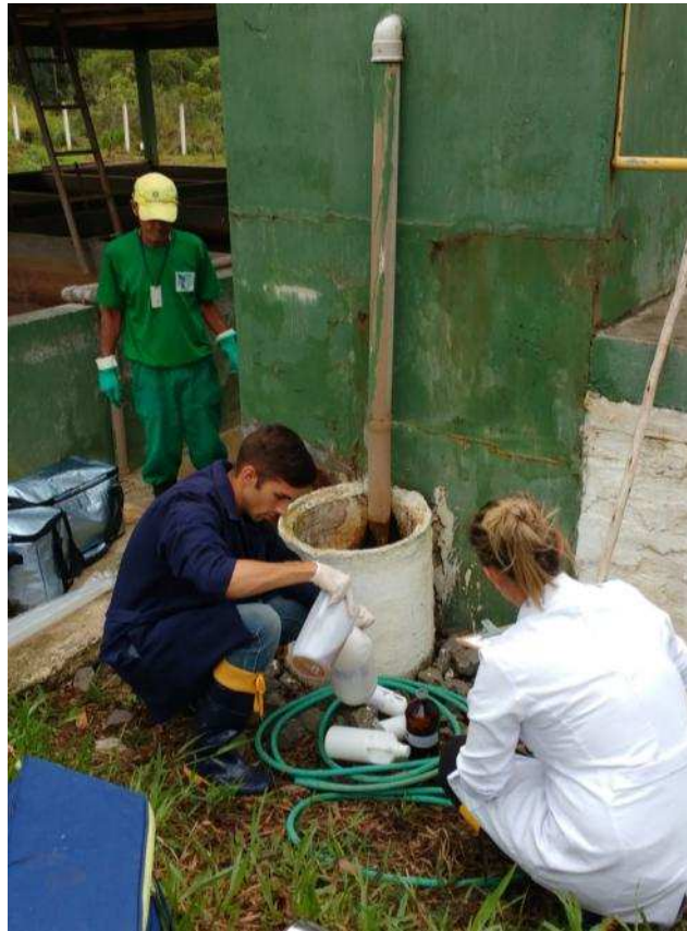
Figura 23: Coleta de Efluente – Saída Físico-Químico – fevereiro de 2017.
