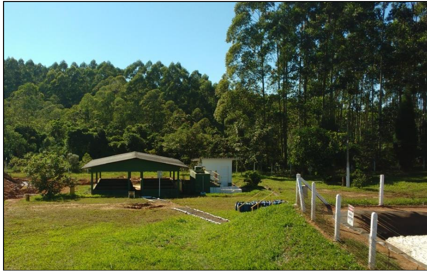
Figura 10: Tratamento Físico-Químico, fevereiro de 2016.
