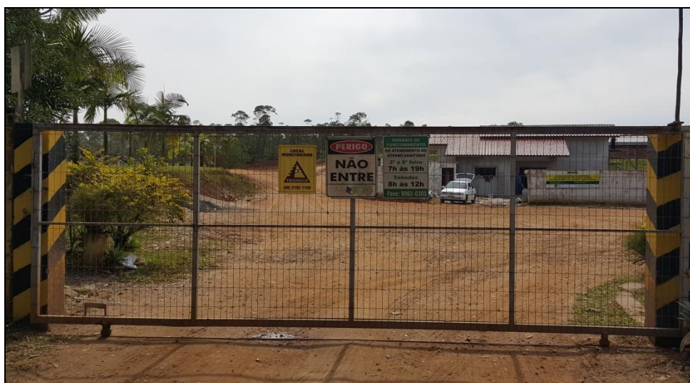
Figura 11: Cerca perimetral e portão de acesso, abril de 2016.
