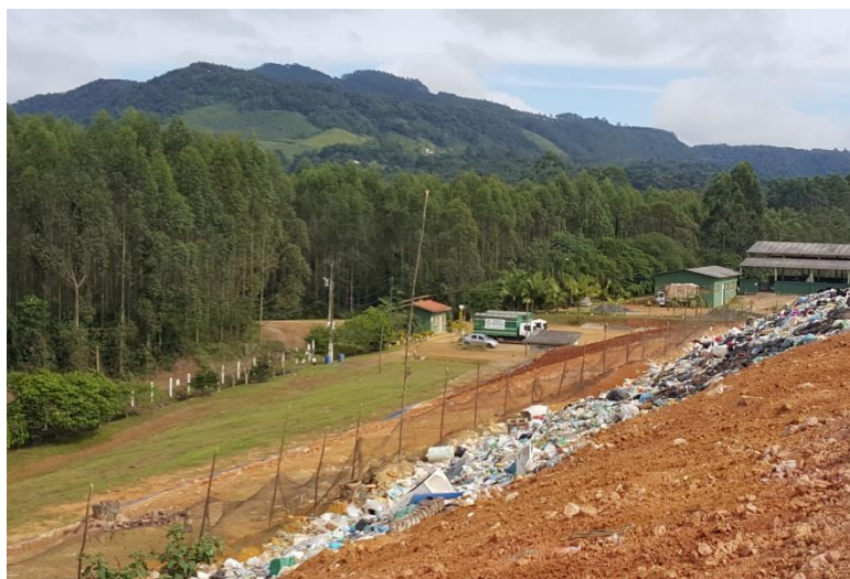
Figura 38: Cercamento provisório, abril de 2016.
