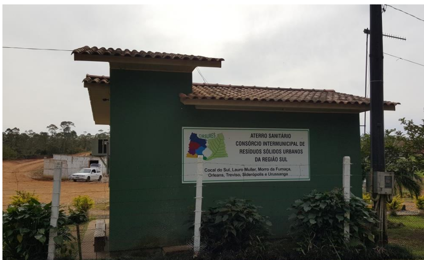
Figura 12: Área externa da Guarita, abril de 2016.
