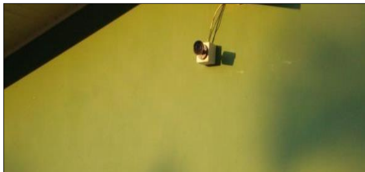
Figura 14: Monitoramento por câmeras, março de 2016.
