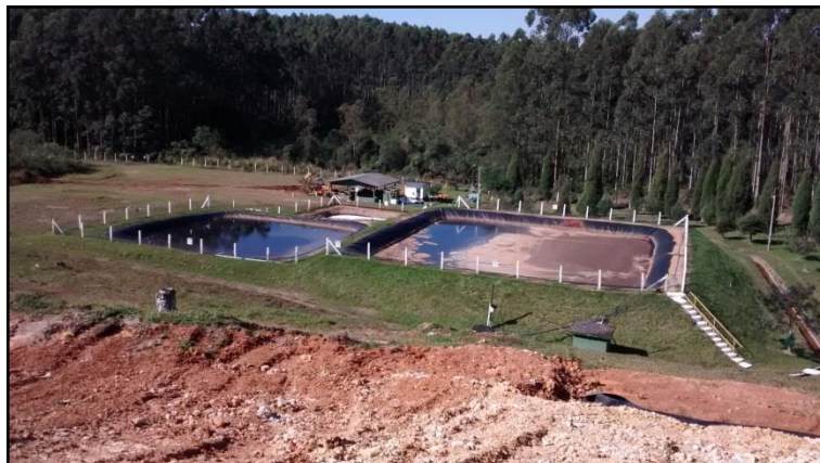
Figura 6: Lagoas anaeróbias - Sistema de tratamento de lixiviado, abril de 2015.
