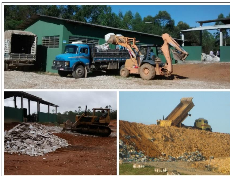
Figura 20: Máquinas utilizadas na operação do aterro sanitário.
