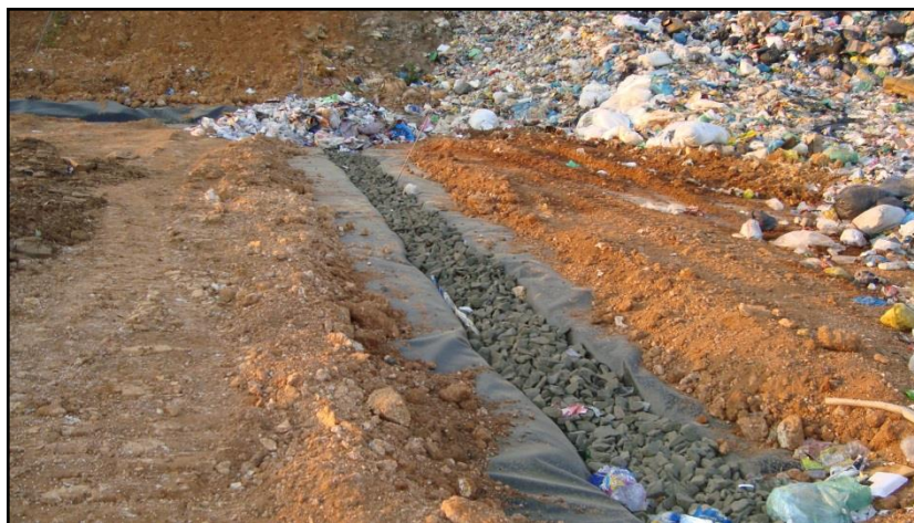
Figura 3: Sistema de drenagem de lixiviado em construção, agosto de 2015.
