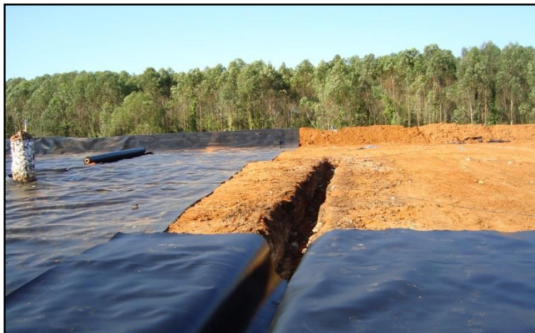
Figura 77: Etapa da instalação da geomembrana na área 1 do aterro sanitário.
