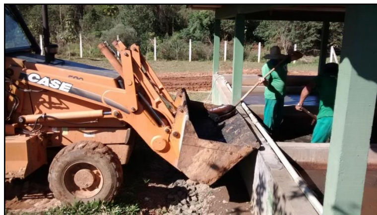
Figura 12: Limpeza dos leitos de secagem do lodo, agosto de 2015.
