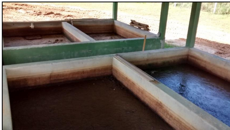
Figura 11: Leitos de secagem do lodo na ETE, agosto de 2015.
