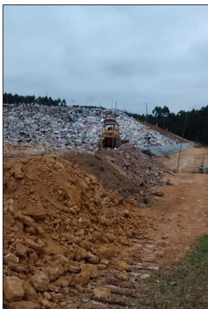
Figura 47: Cercamento provisório da frente de serviço.
