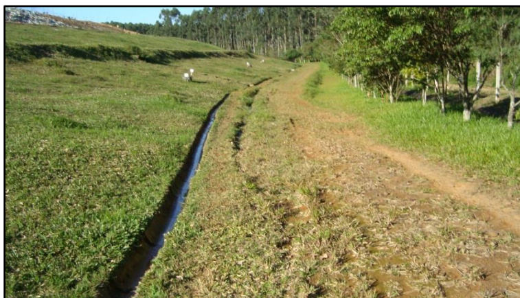
Figura 51: Grama plantada nas faces dos taludes, agosto de 2015.
