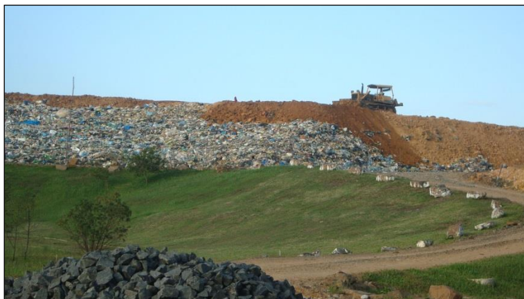
Figura 46: Recobrimento dos RSU.
