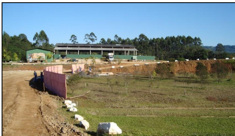
Figura 78: Instalação dos tapumes da obra, julho de 2015.
