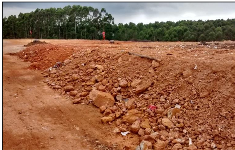
Figura 50: Nivelamento do talude do aterro sanitário.
