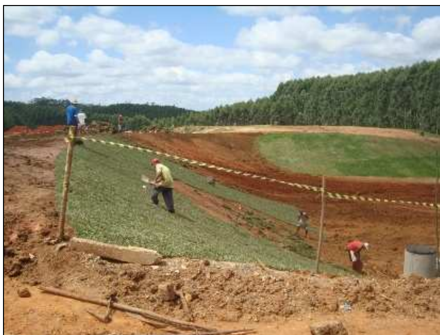
Foto 10: Aplicação de gramíneas no talude da área 2, março de 2010.
