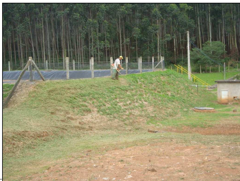
Foto 7: Serviço de roçada e manutenção do aterro sanitário, março de 2010.
