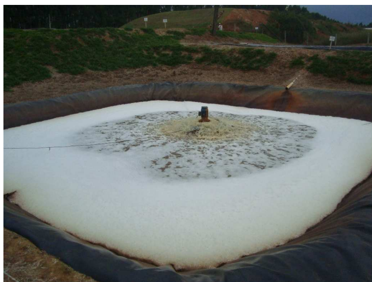
Foto 13: Lagoa 3 com aerador de superfície, março de 2010.
