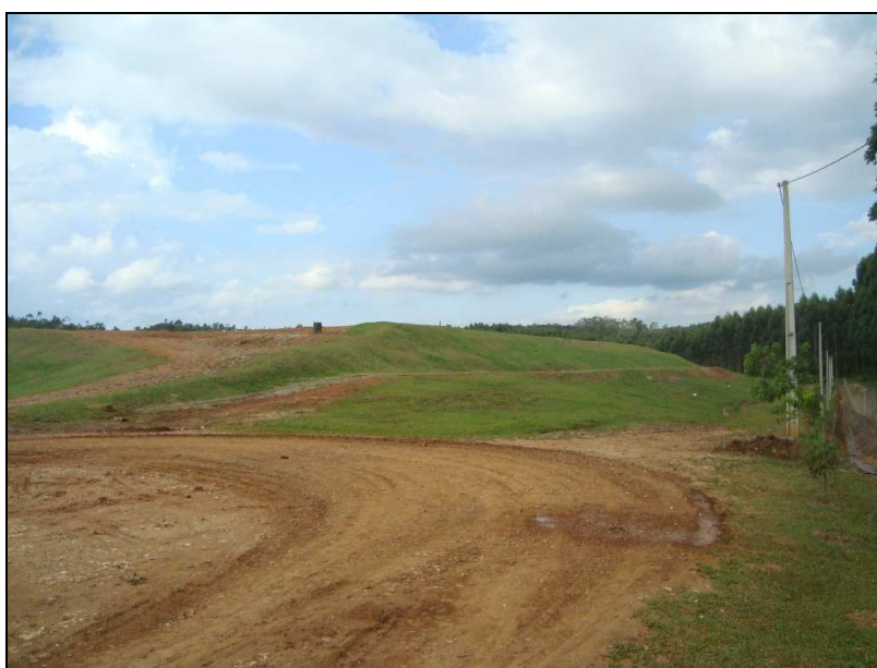
Foto 9: Vista geral dos taludes da área1( finalizada), março de 2010.
