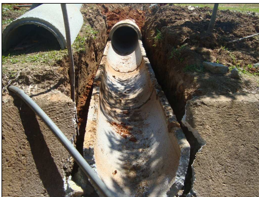
Foto 11: Instalação de drenagem pluvial, março de 2010.
