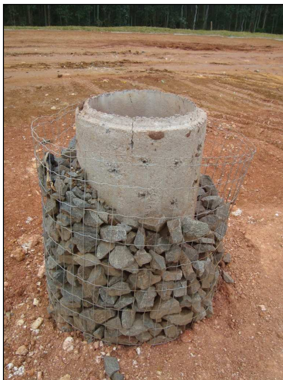
Foto 6: Drenagem de gases, com brita 4, tubo e tela, março 2010.
