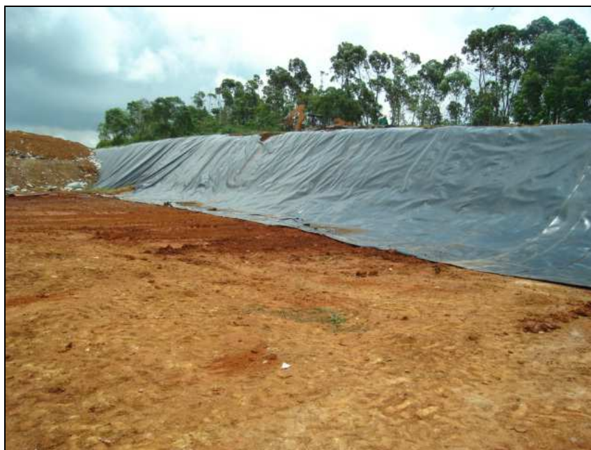
Foto 17: Instalação da geomembrana no talude da área 4, dezembro de 2009.
