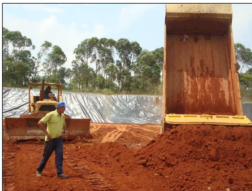
Foto 20: Colocação de argila formando a proteção mecânica, dezembro de 2009.
