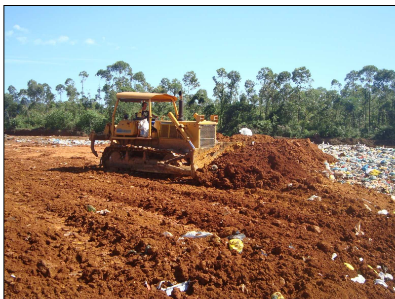
Foto 2: Cobertura diária da frente de serviço, fevereiro de 2010.
