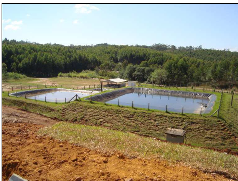
Foto 12: Vista do sistema de tratamento chorume, agosto 2009.
