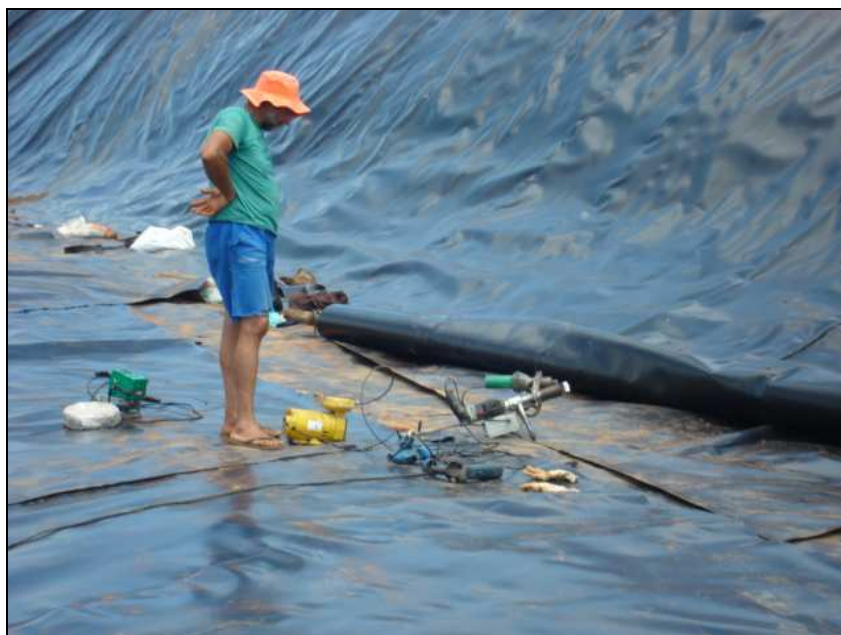
Foto 18: Equipe da Engepol realizando a instalação, dezembro de 2009.
