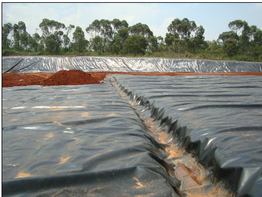
Foto 19: Base aterro impermeabilizada e canal de drenagem, dezembro 2009.
