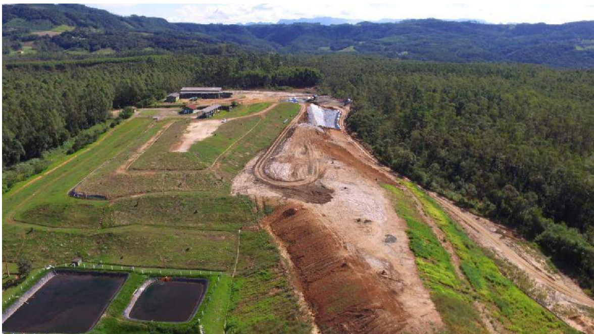
Figura 4: Detalhe do estágio atual do avanço da segunda bancada.
