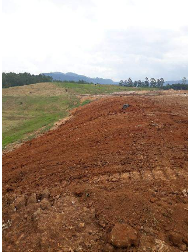
Figura 1: Detalhe da segunda bancada já implantada com cobertura de solo orgânico e dreno de gases.
