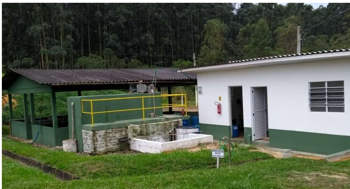
Figura 10: Tratamento Físico-Químico, destaque para ampliação da casa de química, maio de 2019.
