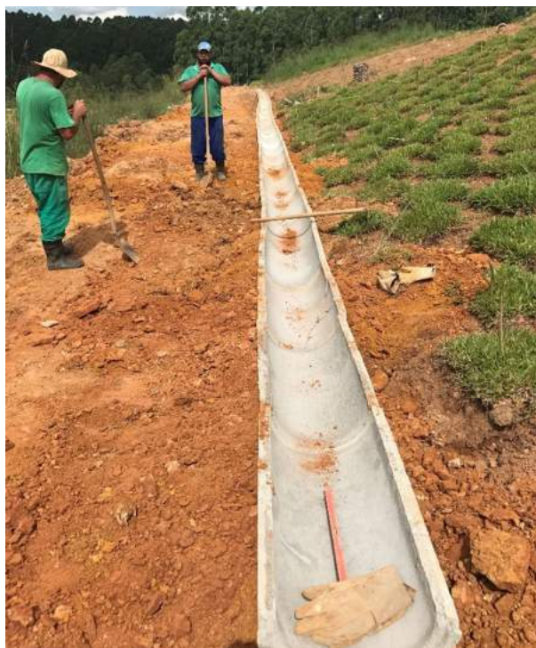
Figura 6: Sistema de drenagem pluvial em evolução, junho 2018.
