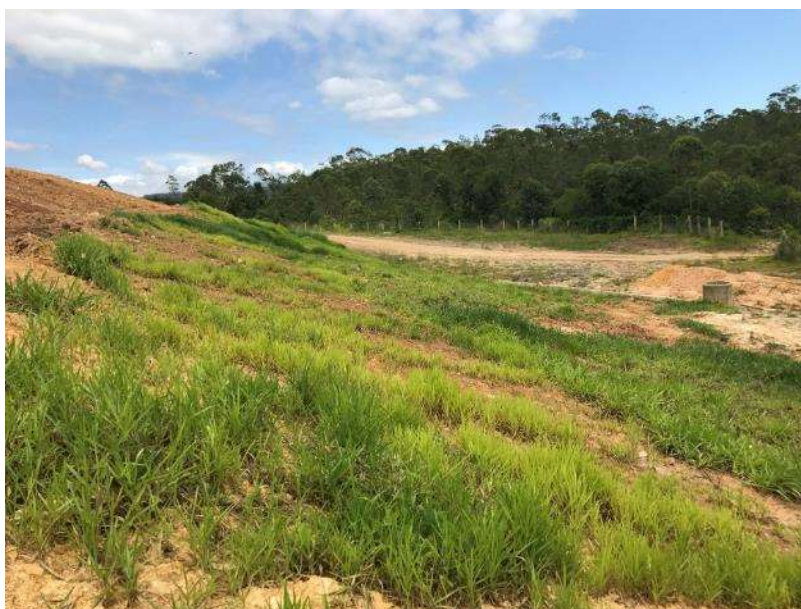
Figura 17: Plantio de gramíneas nos taludes, dezembro de 2018.
