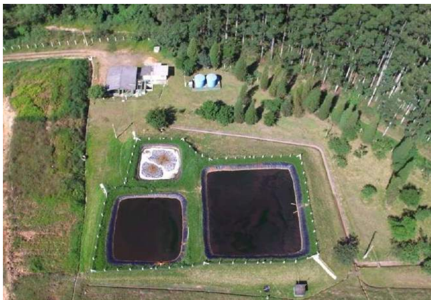
Figura 8: Vista aérea do sistema de tratamento de chorume, abril de 2019.
