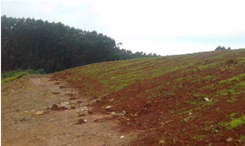
Figura 2: Detalhe da porção norte do talude da segunda bancada, onde se percebe que a cobertura vegetal encontra-se em desenvolvimento.
