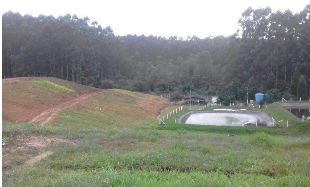
Figura 5: Detalhe da berm entre os taludes da primeira e segunda bancada na face sul do aterro.
