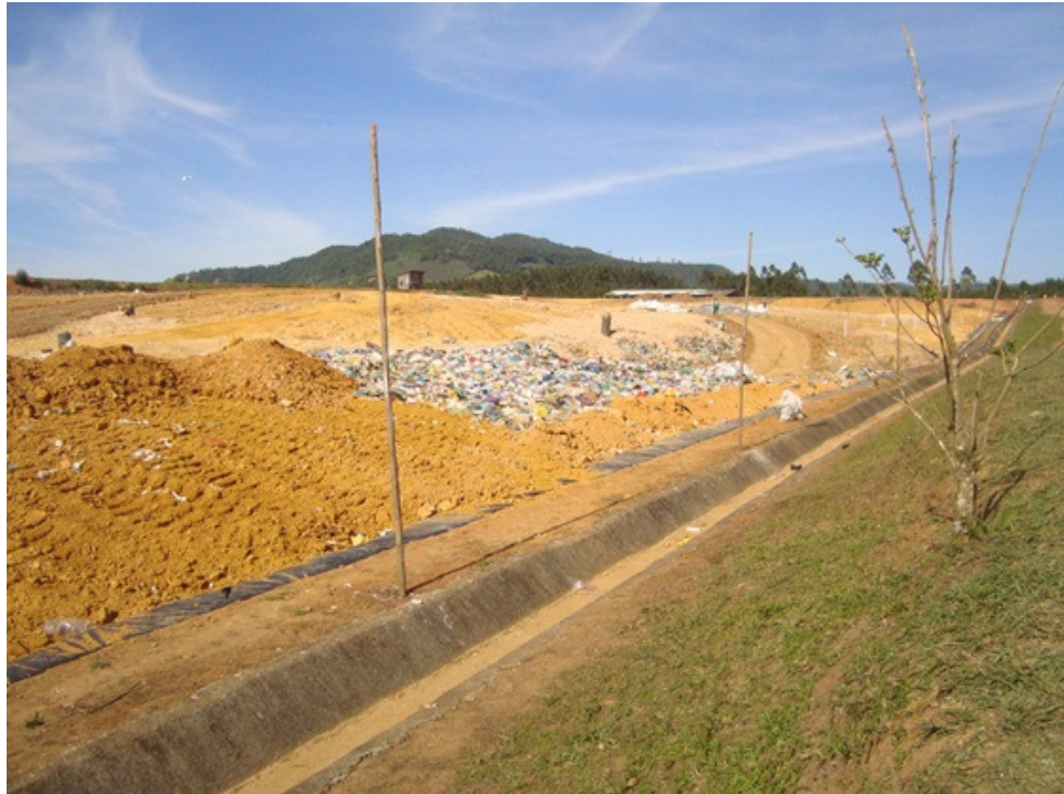
Figura 3: Vista geral da frente de serviço, dezembro de 2011.
