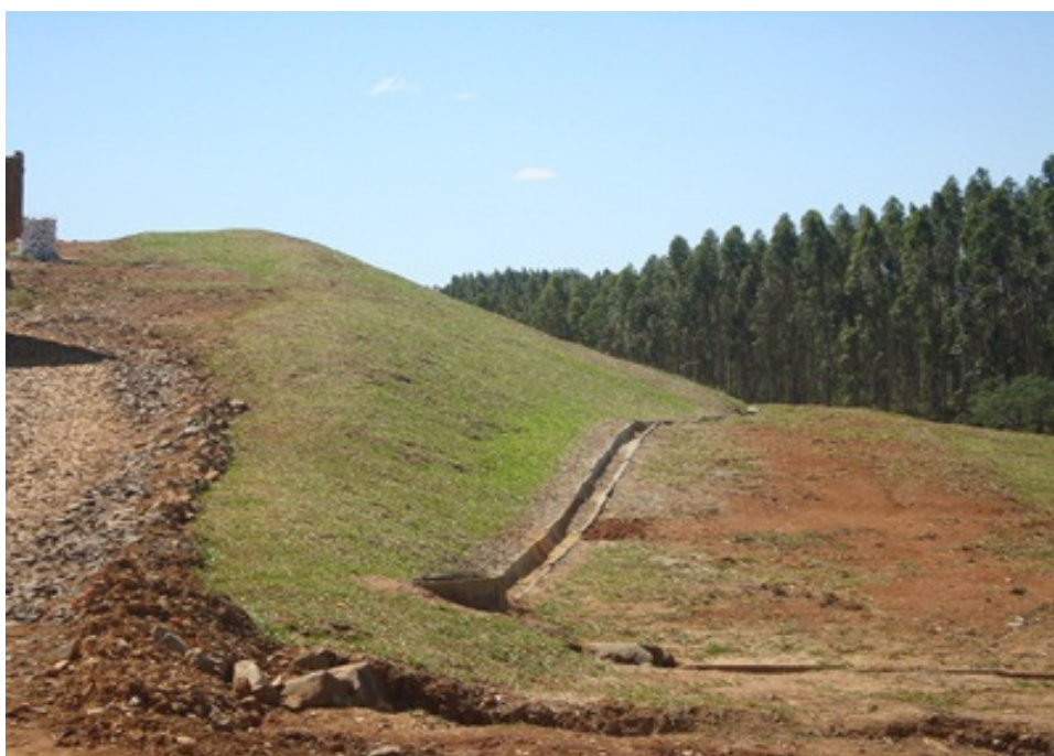
Figura 6: Vista do talude com detalhe drenagem pluvial, dezembro de 2011.
