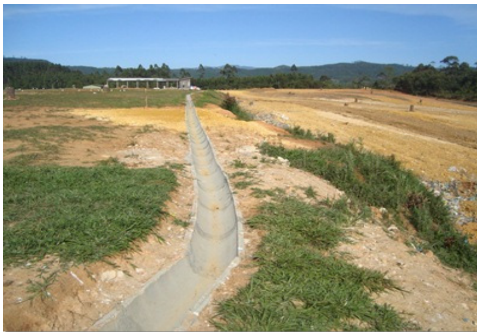
Figura 8: Instalação 150 metros canaletas, outubro de 2011.
