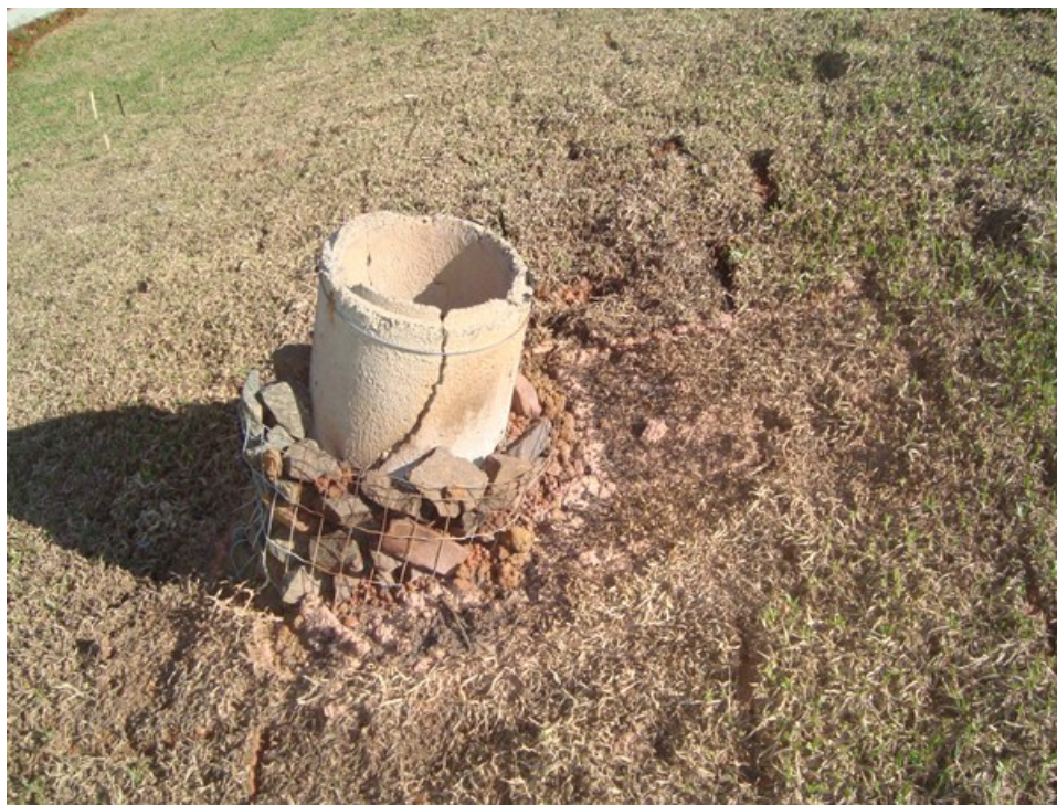
Figura 4 : Drenagem de gases, novembro de 2011.
