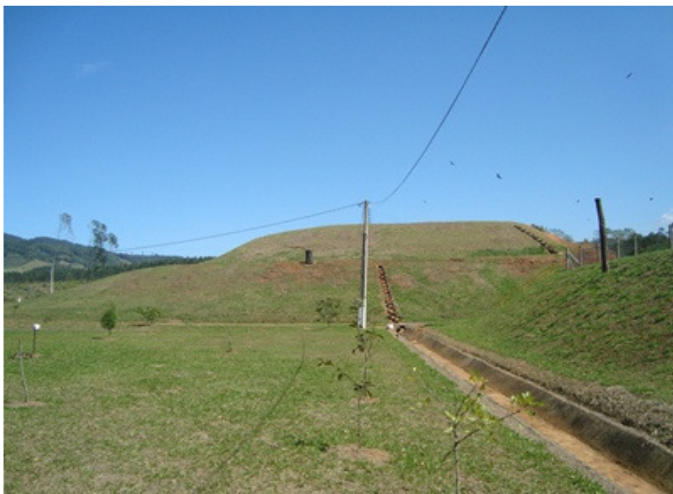
Figura 5: Vista geral do talude área 1 dezembro de 2011.
