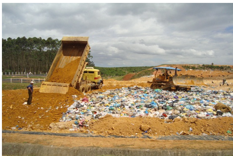
Figura 2: Compactação massa de resíduos da frente de serviço, novembro de 2011.
