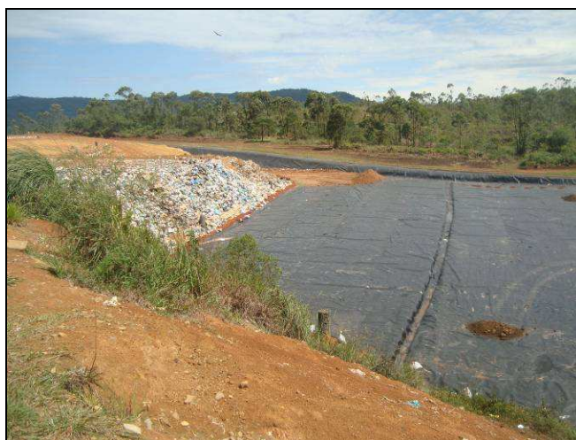
Figura 21: Instalação da geomembrana, dezembro de 2010.
