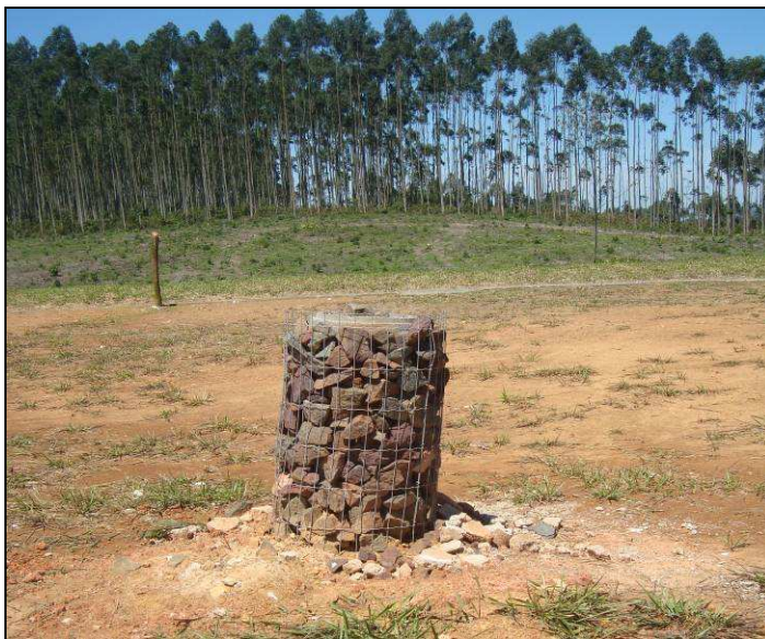
Figura 7: Drenagem de gases, com brita 4, tubo e tela, dezembro de 2010.
