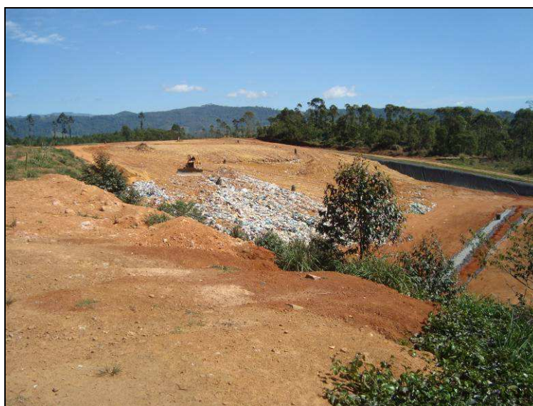
Foto 5: Vista geral da frente de serviço, novembro de 2010.
