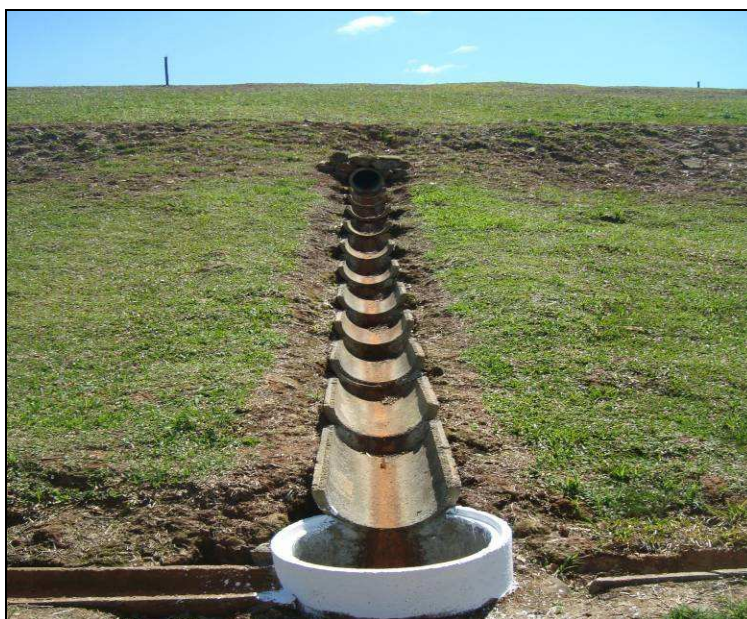
Figura 12: Instalação dos dissipadores de energia, junho de 2010.
