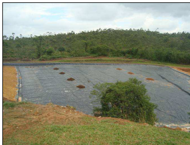
Figura 22: Vista geral da impermeabilização, dezembro de 2010.
