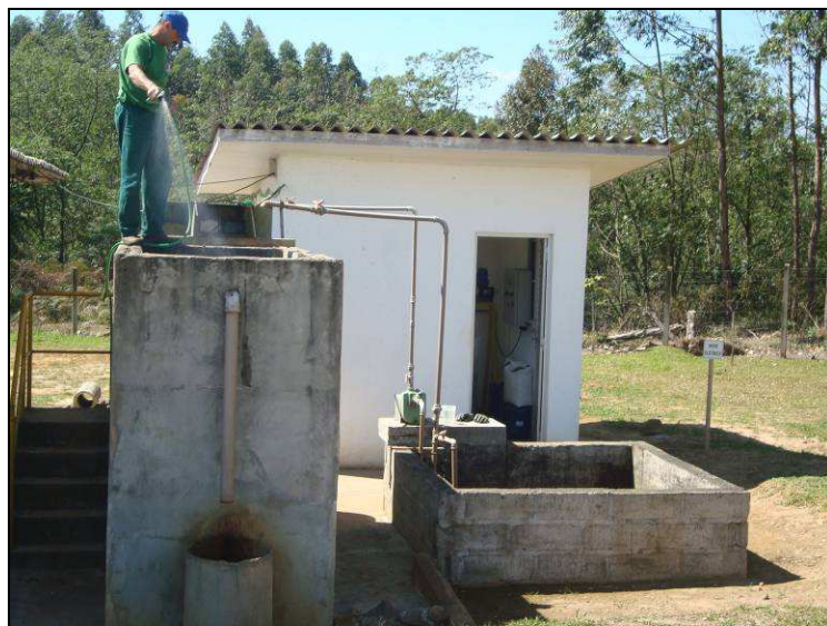
Figura10: Manutenção da estação física químico, janeiro de 2011.
