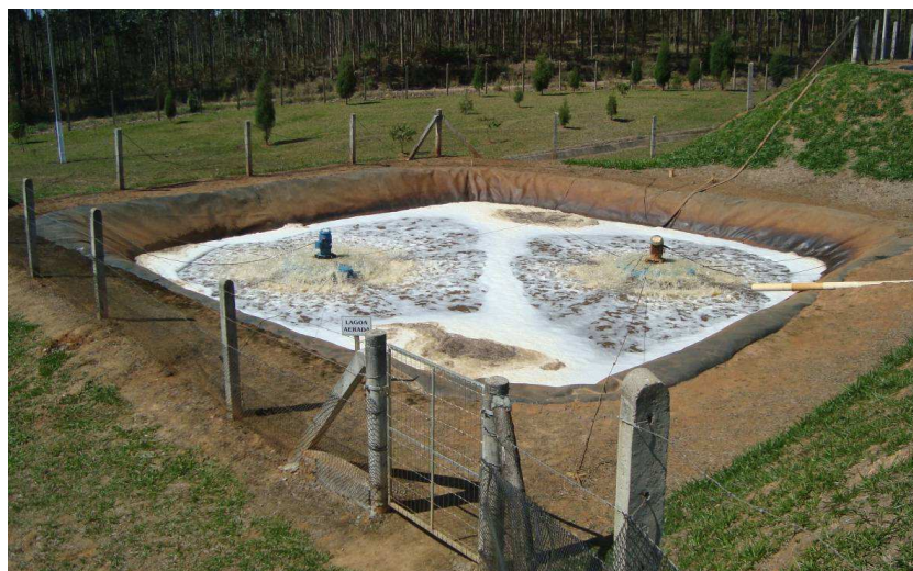
Foto 16: Lagoa 3 (aerada) com os dois aeradores de superfície, e a recirculação de chorume para da lagoa 3 para a lagoa 1, janeiro de 2011.
