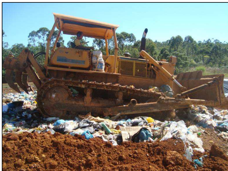
Figura 2: Compactação massa de resíduos da frente de serviço, novembro de 2010.
