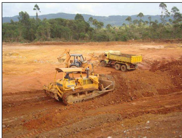
Figura 3: Destoca de argila cobertura da frente de serviço, novembro de 2010.
