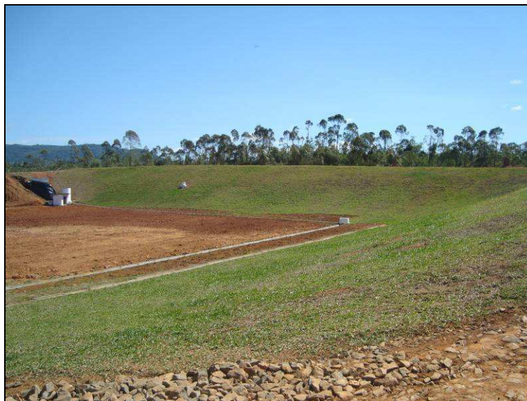
Figura 8: Vista geral dos taludes roçada e manutenção, dezembro de 2010.
