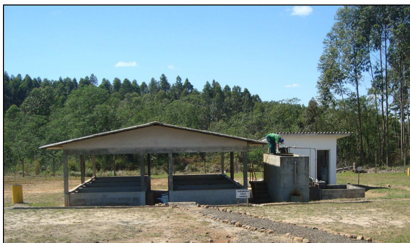
Foto 15: Vista do sistema de tratamento físico-químico de chorume. No lado esquerdo pode ser observado, em amarelo, um poço piezométrico, agosto 2009.
