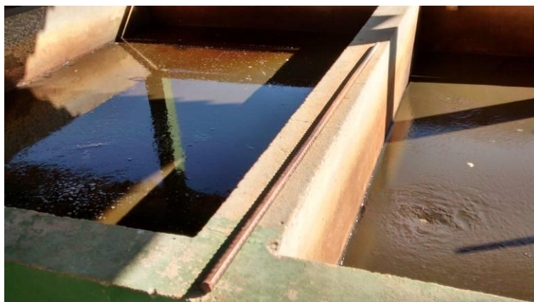
Figura 8: Leitões de secagem do lodo na ETE físico-química, agosto de 2014.
