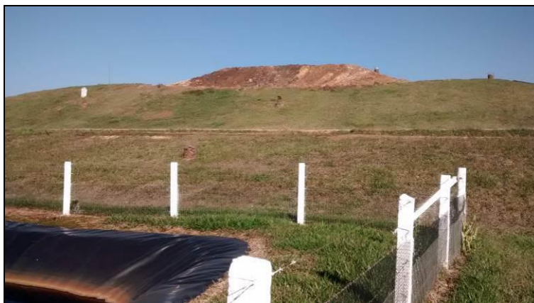
Figura 3: Cobertura da massa de resíduos sólidos. Agosto de 2014.
