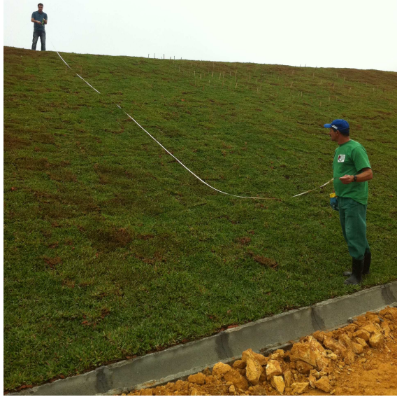
Figura 4: Fixação e medição das gramas no talude, setembro de 2013.
