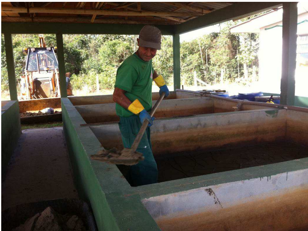
Figura 06: Retirada do lodo dos leitos secagem – ETE físico -química, outubro de 2013.
