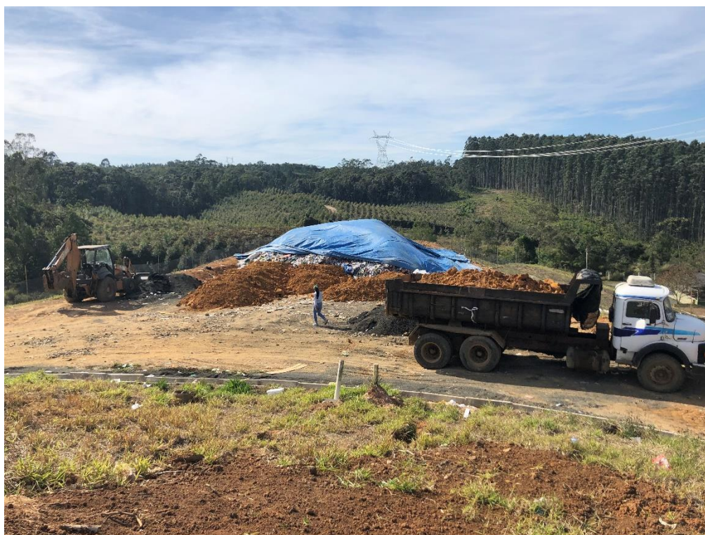
Figura 5: Utilização da manta de sacrifício em períodos chuvosos, junho 2021.
