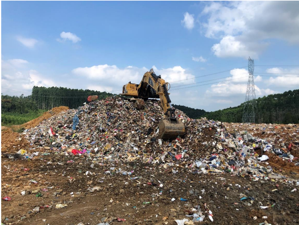
Figura 17: Escavadeira em operação, maio 2022.
