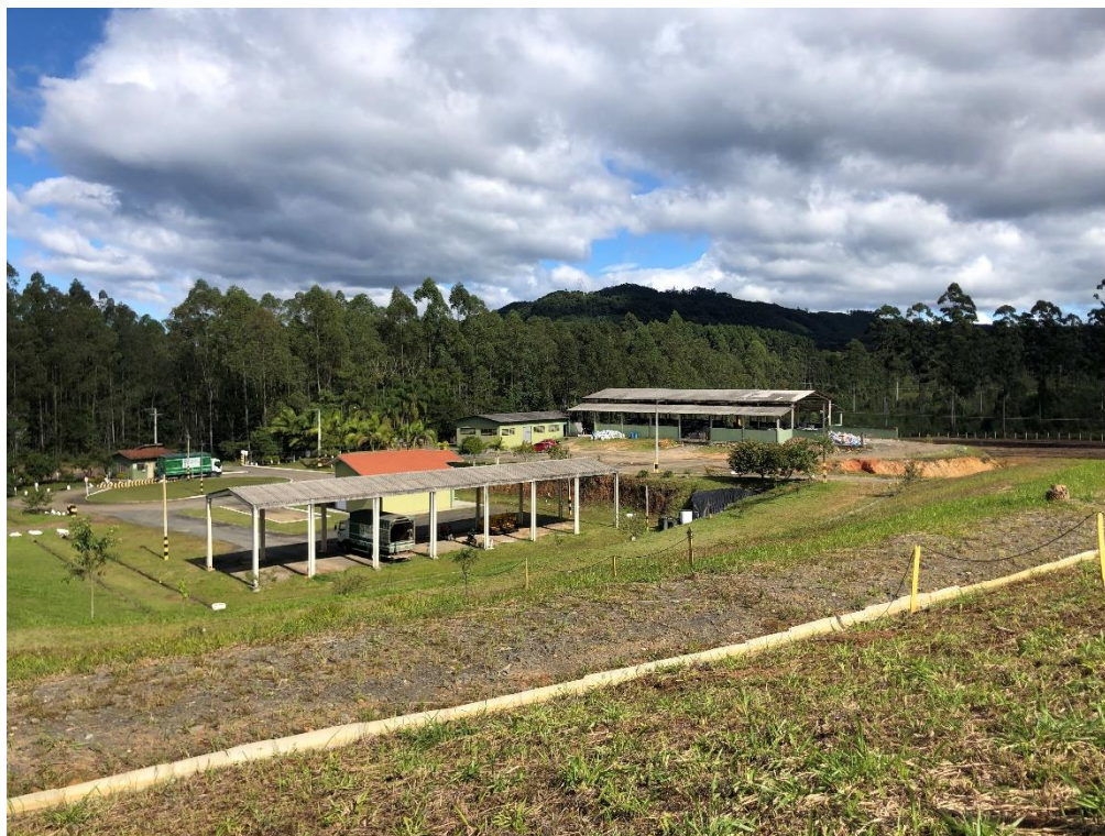
Figura 16: Imagem geral da guarita, balança, auditório e galpões, abril de 2022.
