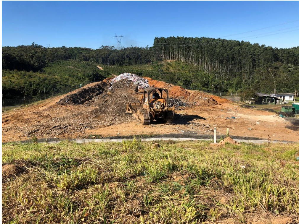
Figura 3: Vista da área de disposição de resíduos, maio de 2021.
