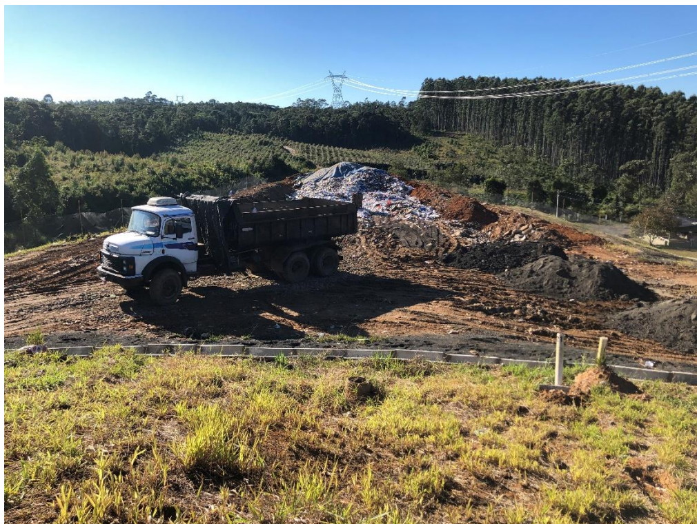
Figura 4: Vista da área da final de disposição de resíduos, junho de 2021.
