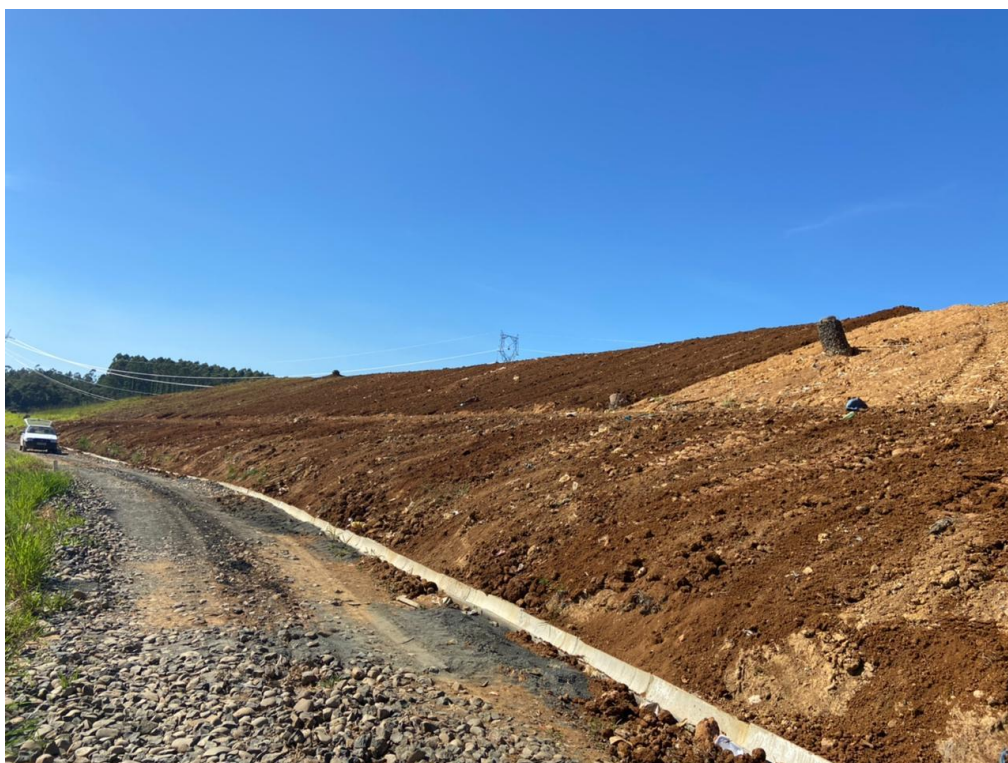
Figura 8: Instalação de drenagem pluvial, maio de 2021.
