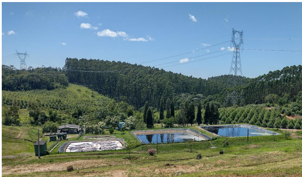
Figura 11 – Vista geral das instalações da ETE biológica – março 2022.
