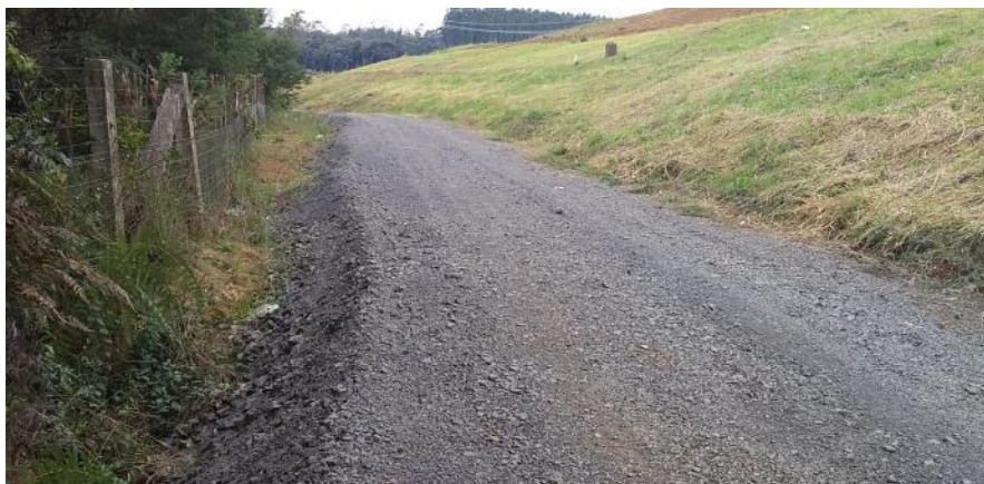
Figura 24: Elevação do nível da estrada para atenuação do possível deslocamento da massa de resíduos.
