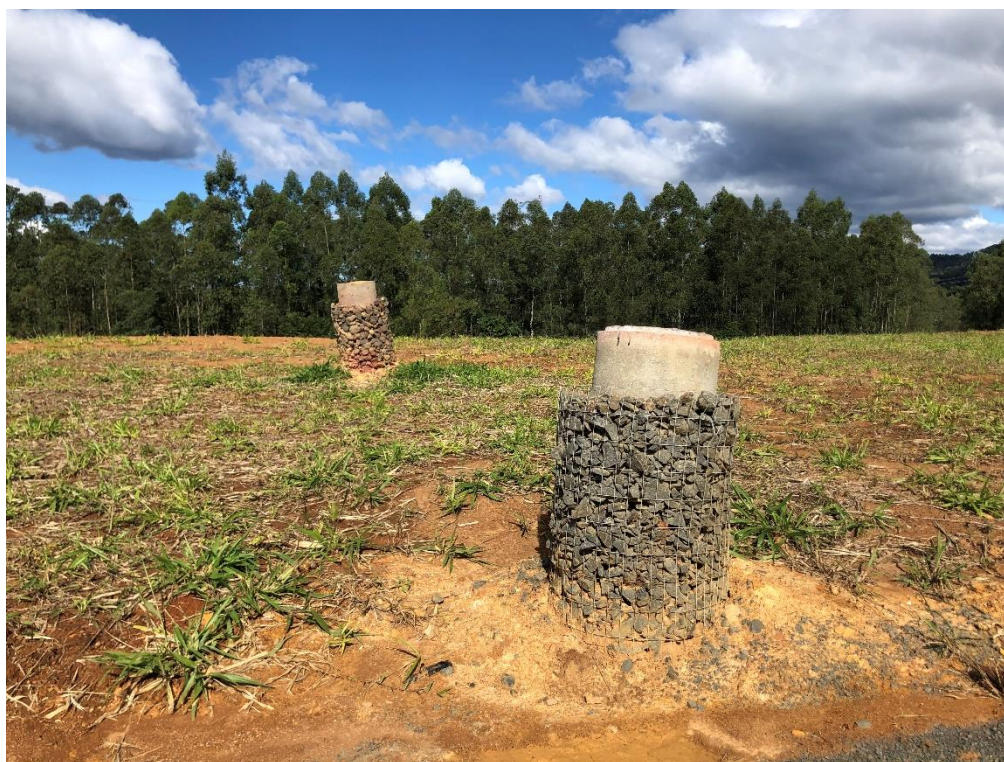
Figura 7: Queimadores de gases, janeiro de 2022.
