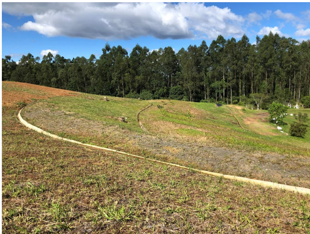
Figura 9: Finalização das drenagens, março de 2022.
