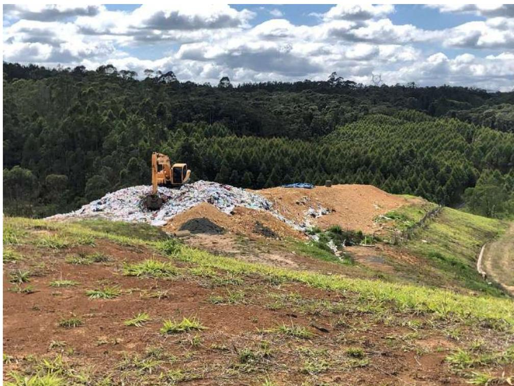
**Figura 4: Conformação dos taludes da disposição de rejeitos, outubro de 2022.**
