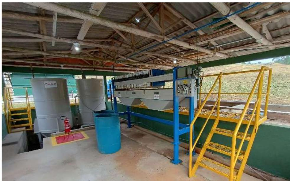
**Figura 12 – Filtro Prensa e tanques adensadores da ETE – maio 2023.**
