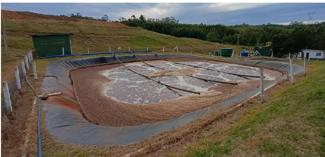
**Figura 12 – Lagoa aerada com novo sistema de aeração Lodos Ativados – maio 2023.**
