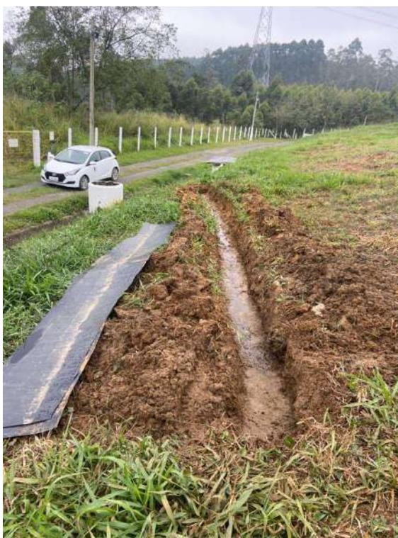
**Figura 21: Controle de vazamento de chorume, agosto de 2022.**
