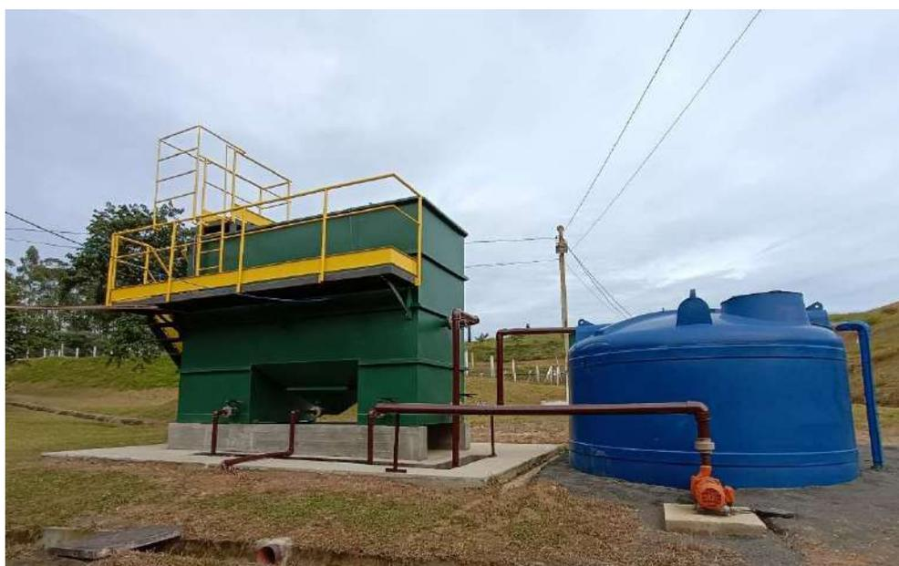
**Figura 13 – Flocodcantador com capacidade de 10 m<sup>3</sup>/h– maio 2023.**
