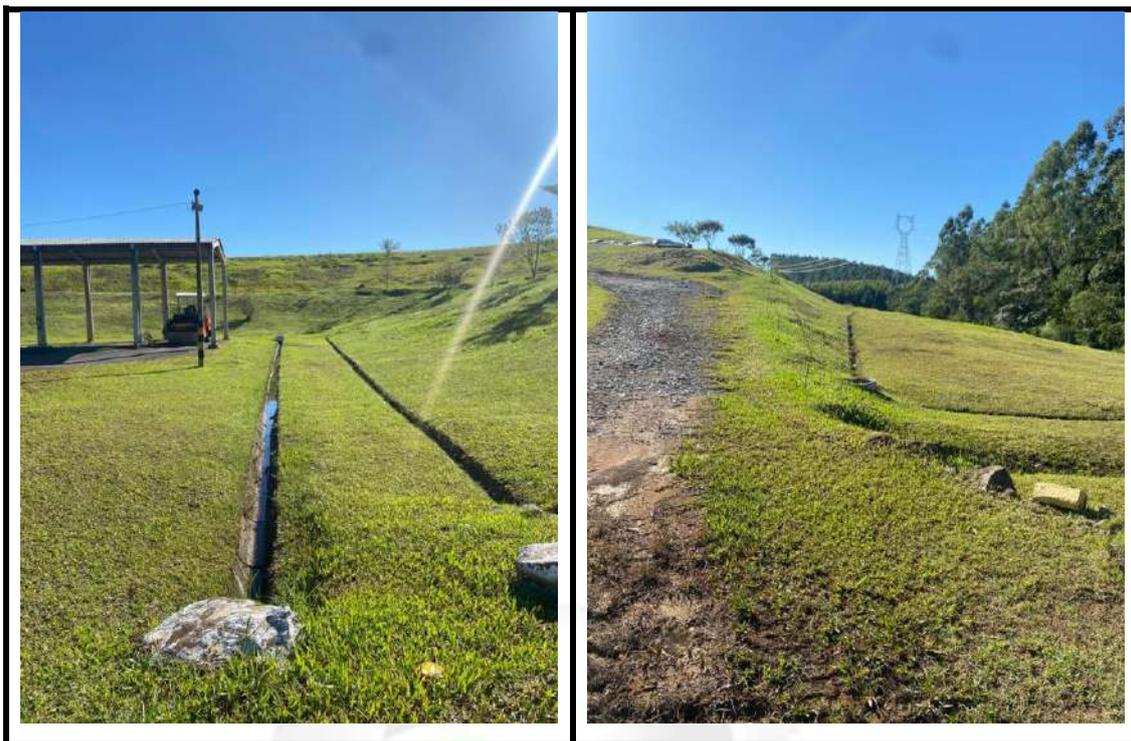
*Figura 3: Sistemas de drenagem de água pluvial.*
