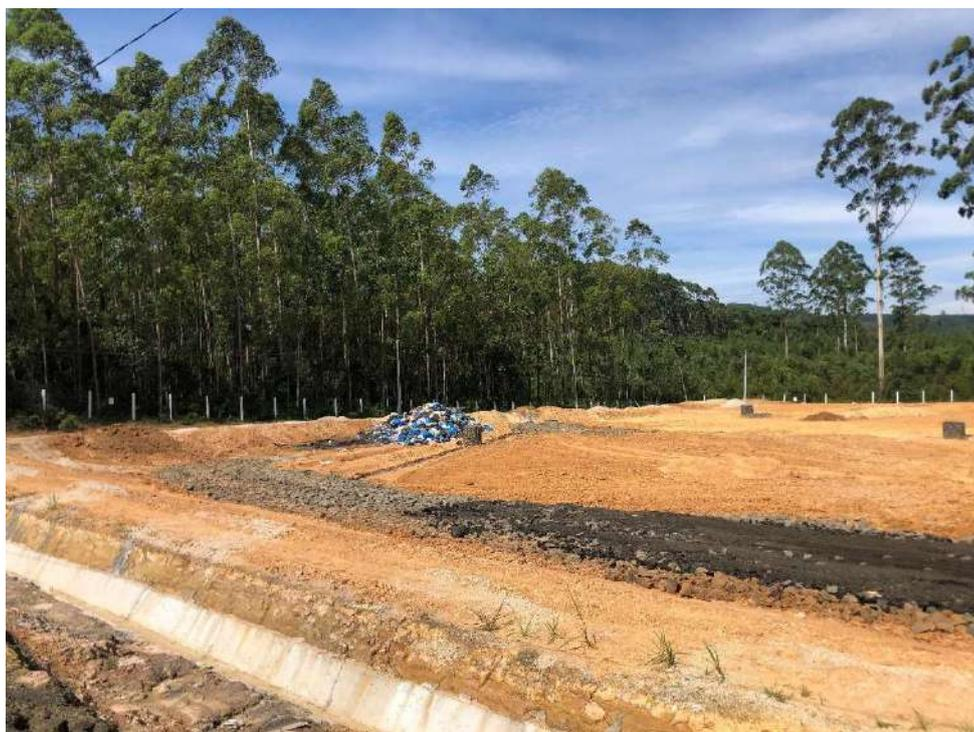
**Figura 9: Drenagem pluvial em concreto da nova célula, janeiro de 2023.**
