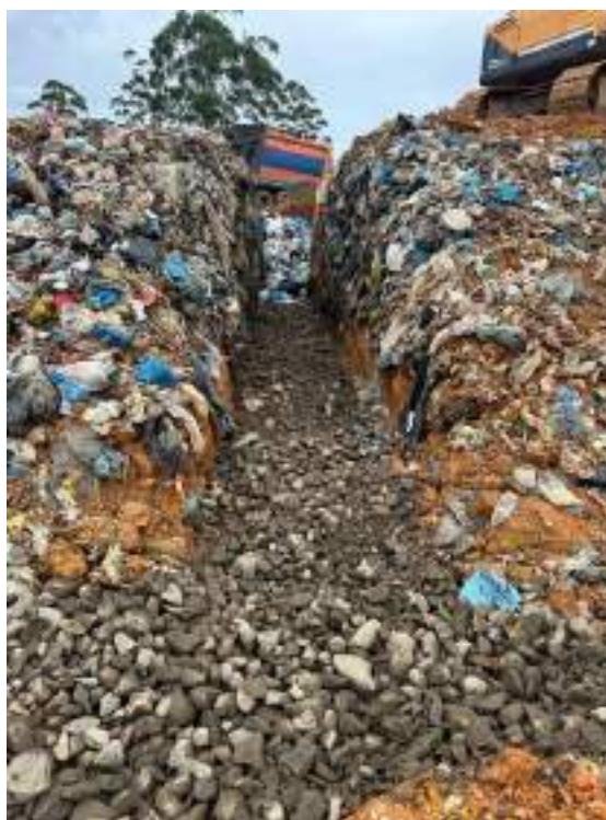
Figura 18: Abertura de drenagens profunda de chorume, dezembro de 2024.
