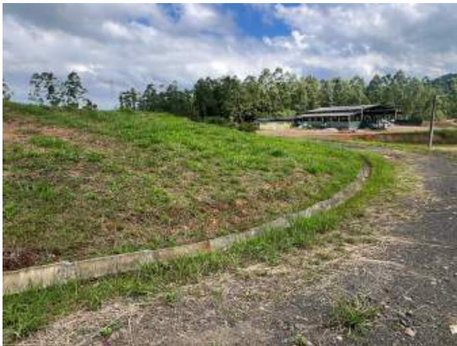
Figura 9: Vista de um trecho de drenagem de águas pluviais.
