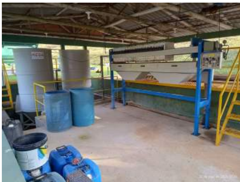
Figura 13 – Filtro Prensa e tanques adensadores da ETE – maio 2025.
