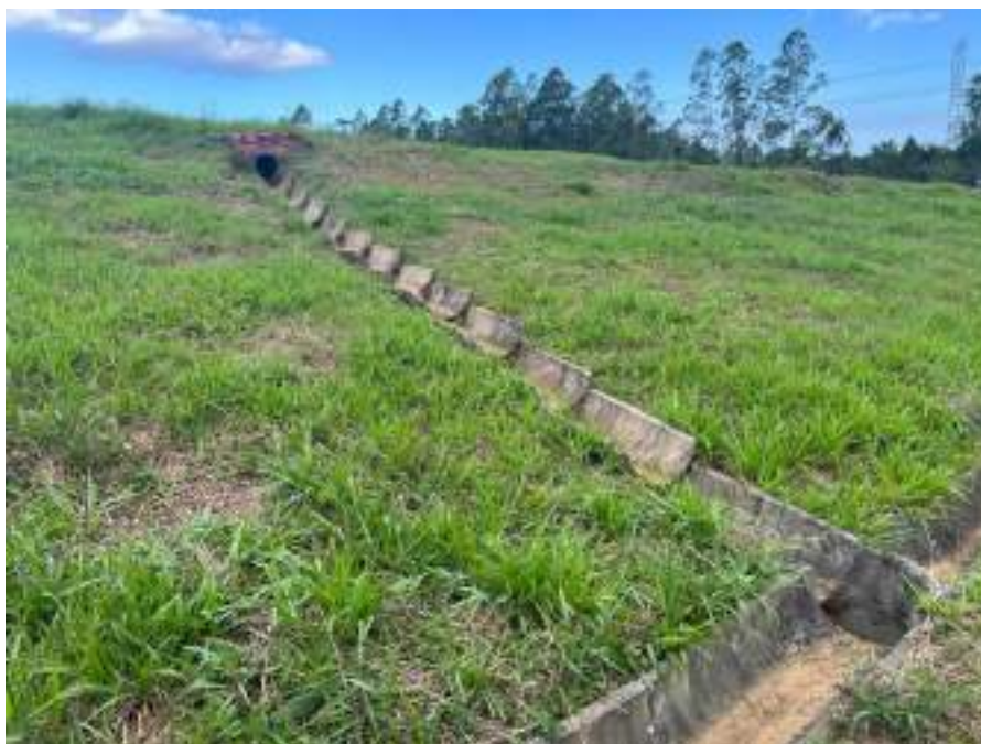
Figura 8: Vista de um trecho de canaletas de drenagem.
