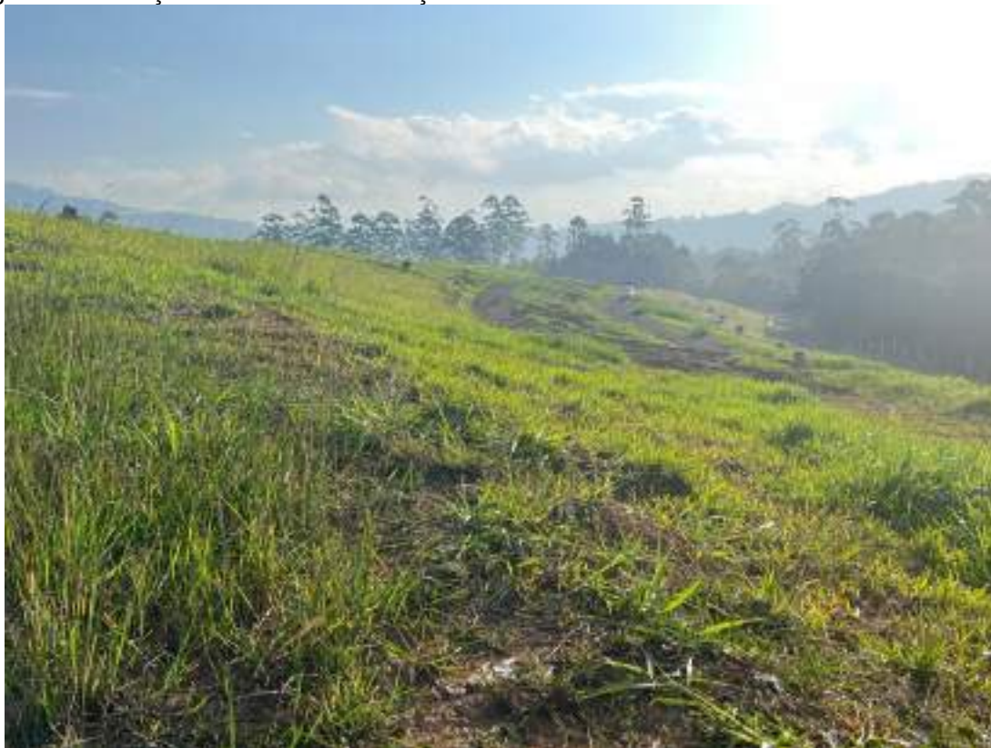
Figura 6: Condição atual da conformação dos taludes vista face norte.
