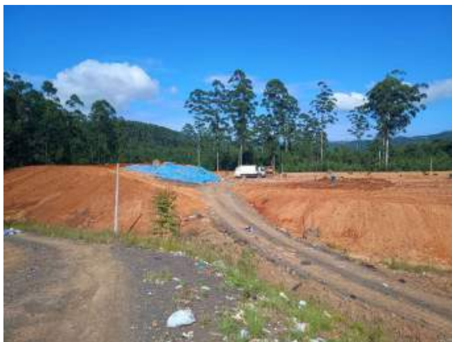
Figura 4: Frente de serviço, agosto de 2024.
