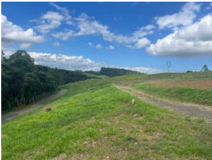
Figura 7: Vista dos taludes pela face norte do aterro, sem indícios de fissuras, trincas ou cunhas de deslizamentos.
