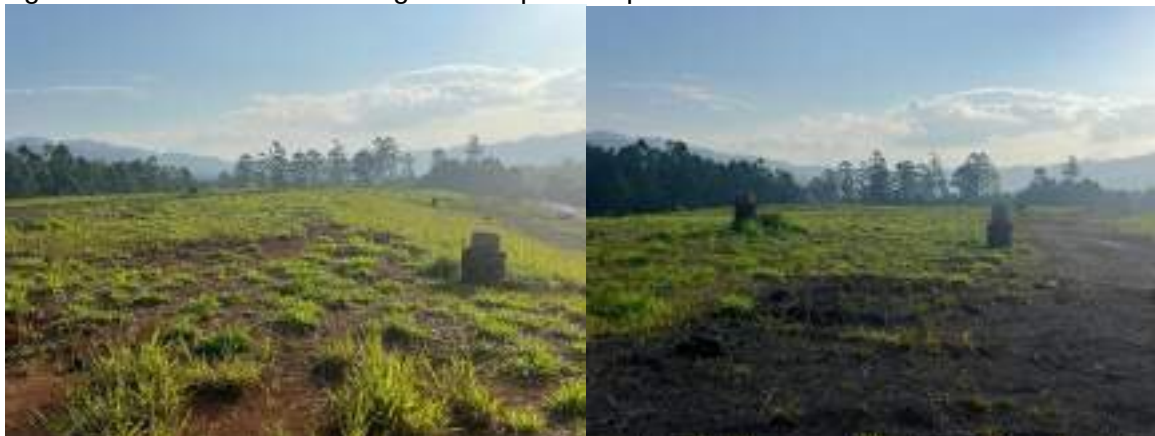
Figura 14: Vista de drenos de gases na parte superior do Aterro.
