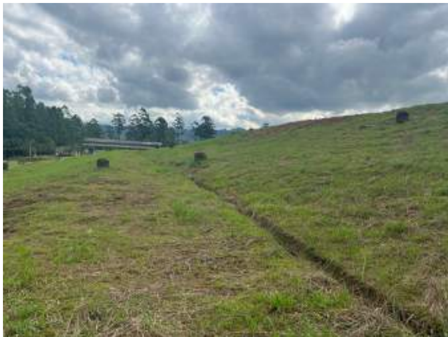
Figura 10: Vista de um trecho de drenagem de águas pluviais.
