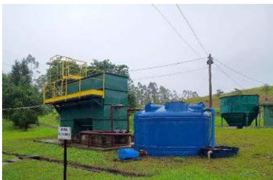
Figura 14 – Floccodecantador com capacidade de 10 m 3 /h– maio 2025.
