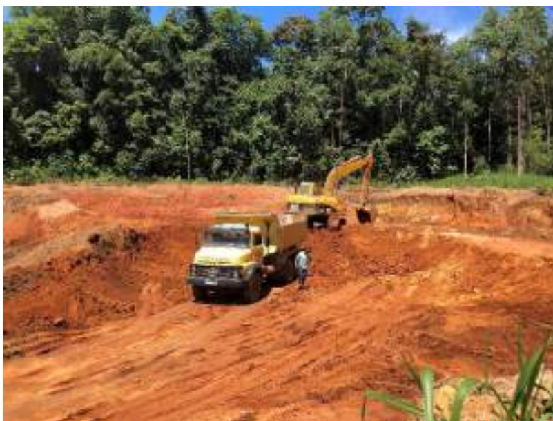
Figura 21: Operação da jazida de argila, maio de 2024.
