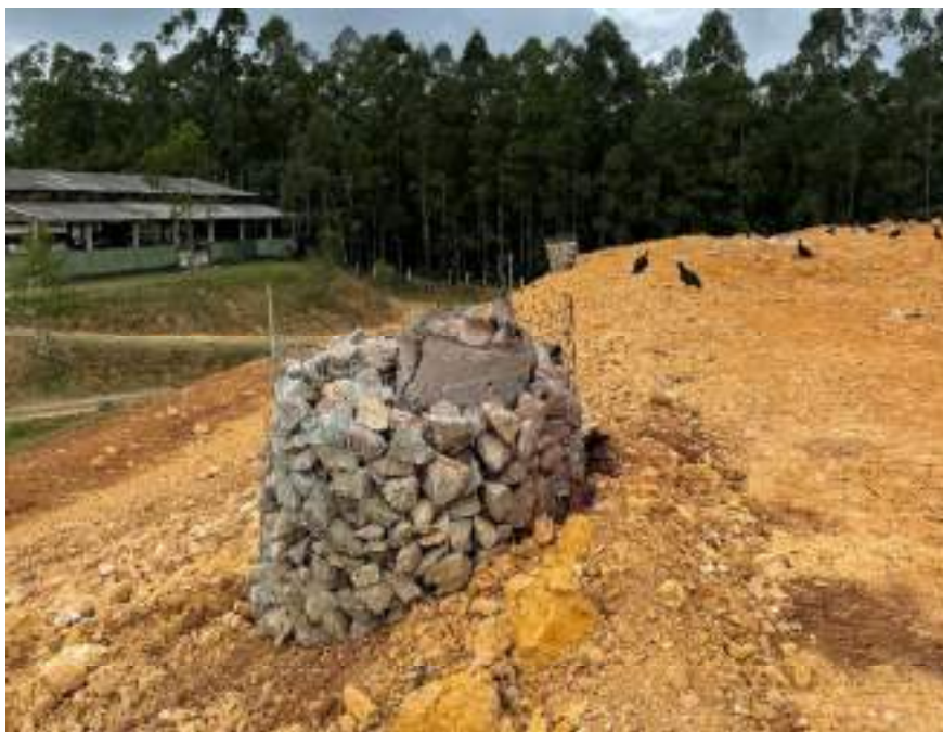
Figura 8: Queimadores de gases na nova célula, abril de 2025.
