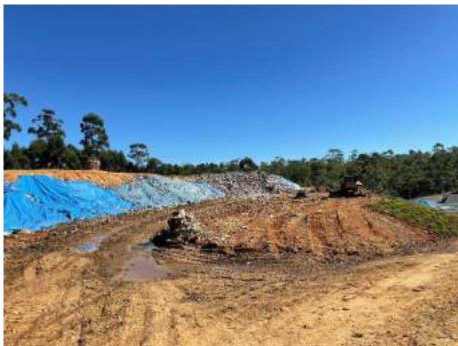
Figura 6: Frente de serviço, fevereiro de 2025.
