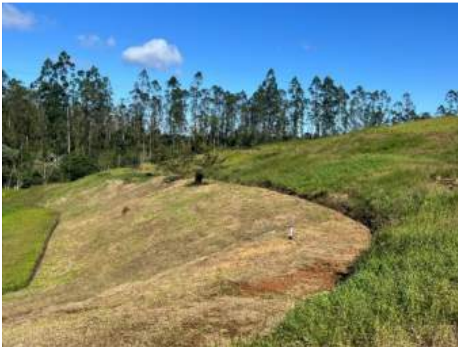
Figura 7: Execução de atividades de manutenção da cobertura vegetal.
