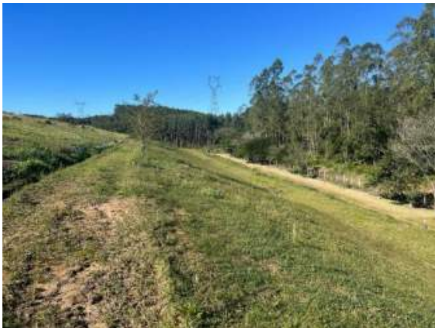
Figura 15: Presença de vegetação de porte arbóreo nas bancadas no Aterro Sanitário.
