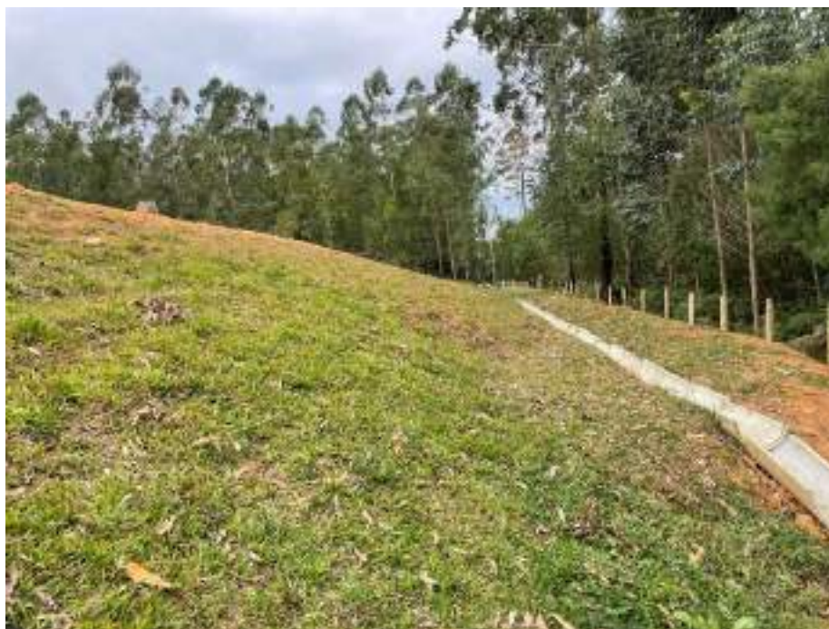
Figura 23: Correção da movimentação de massa, abril de 2025.
