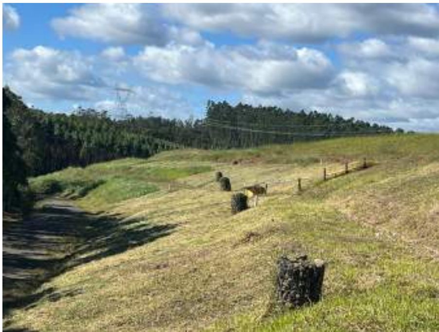
Figura 6: Vista dos drenos de gases da face norte do aterro.
