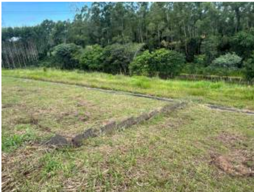
Figura 11: Vista de um trecho do sistema de drenagem.
