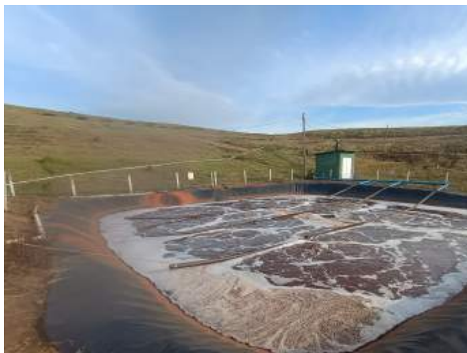
Figura 12 – Lagoa aerada com novo sistema de aeração Lodos Ativados – maio 2025.
