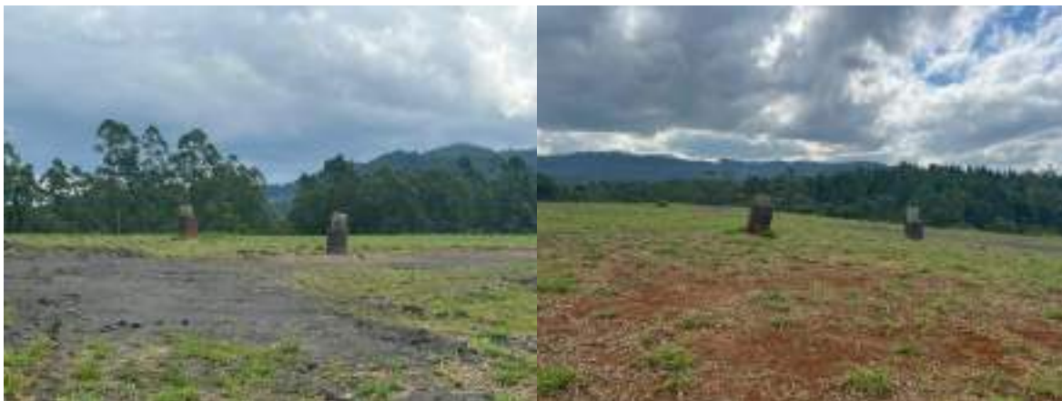
Figura 13: Drenos de gases na parte superior do aterro.
