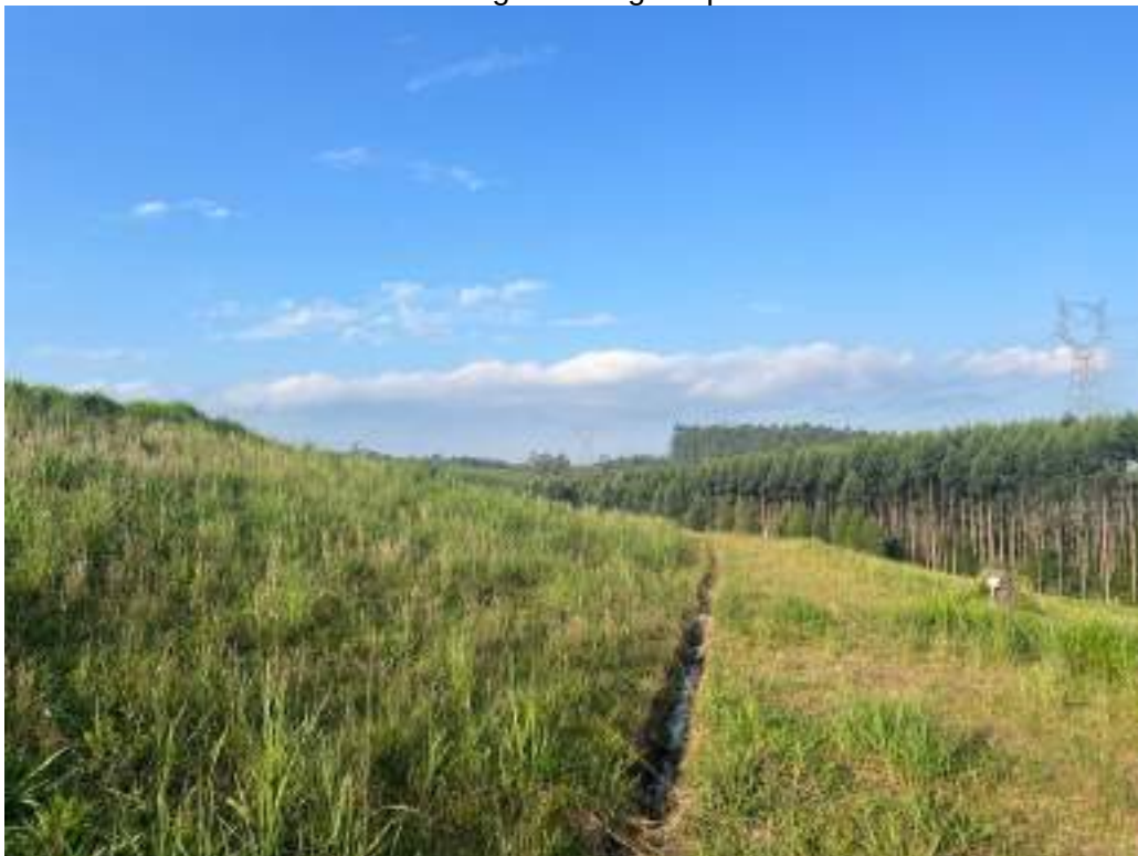
Figura 11: Vista de um trecho de drenagem de águas pluviais.
