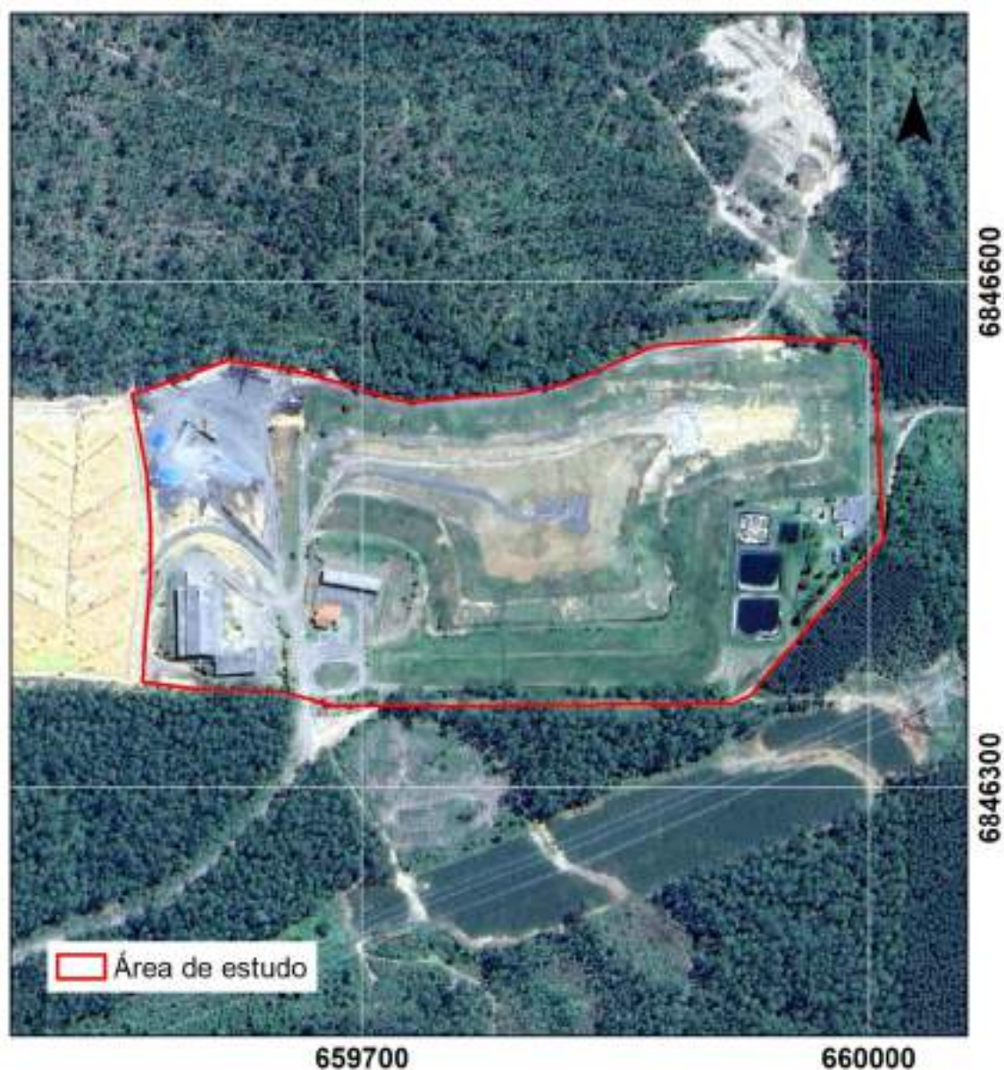
Figura 2: Vista aérea do Aterro de Resíduos Sólidos da CIRSURES.
