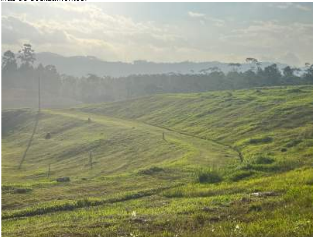
Figura 8: Vista dos taludes pela face norte do aterro, sem indícios de fissuras, trincas ou cunhas de deslizamentos.
