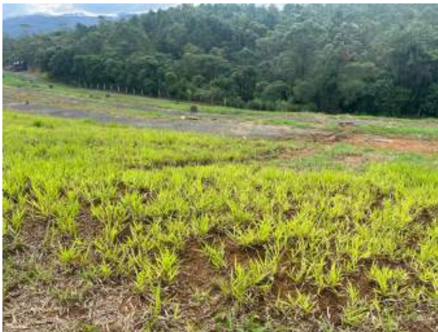
Figura 17: Plantio de gramíneas nos taludes para evitar o desenvolvimento de erosão e drenagens.
