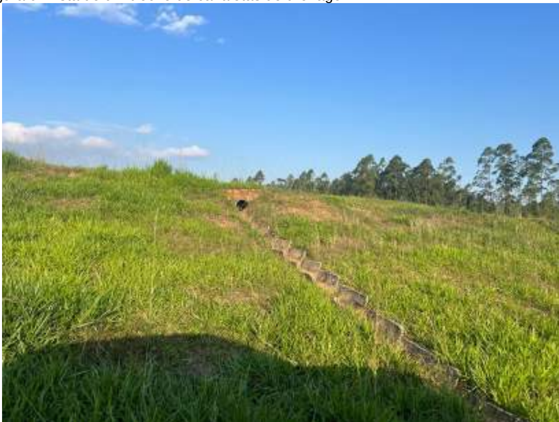
Figura 9: Vista de um trecho de canaletas de drenagem.
